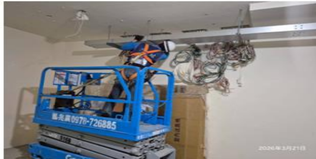
說明：管路配管施作
