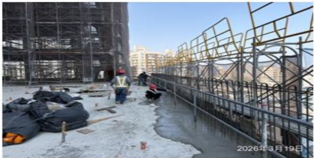
說明：混凝土澆置
