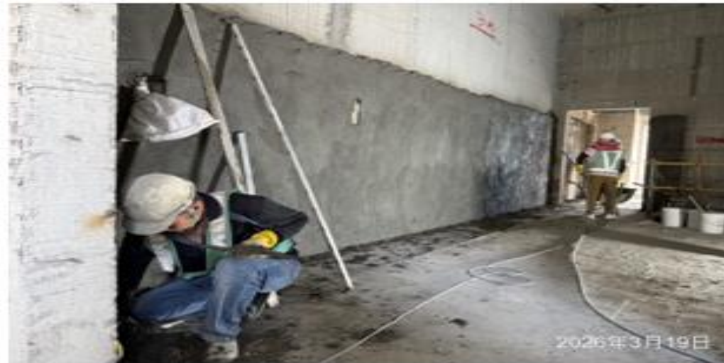
說明：泥作打底粉刷
