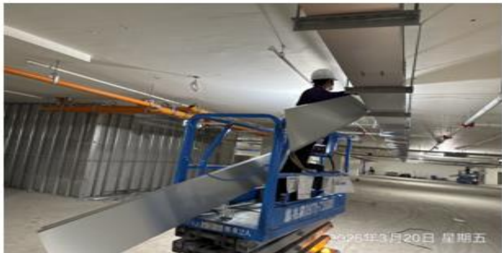
說明：管路配管施作
