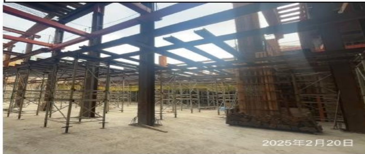
說明：重型支撐架定位。
