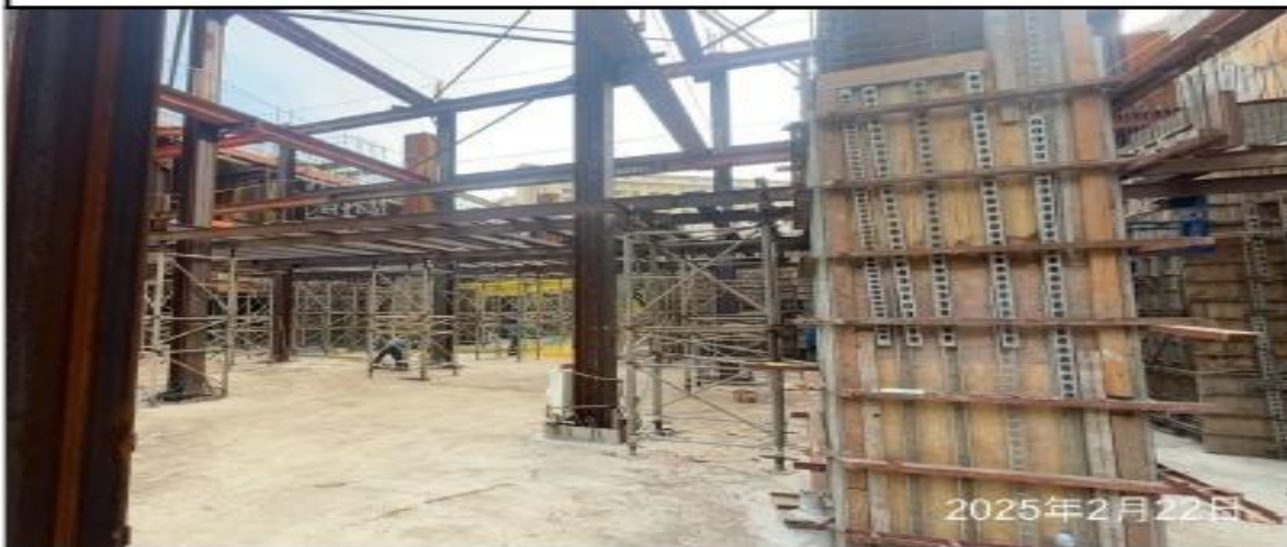
說明：重型支撐架定位。
