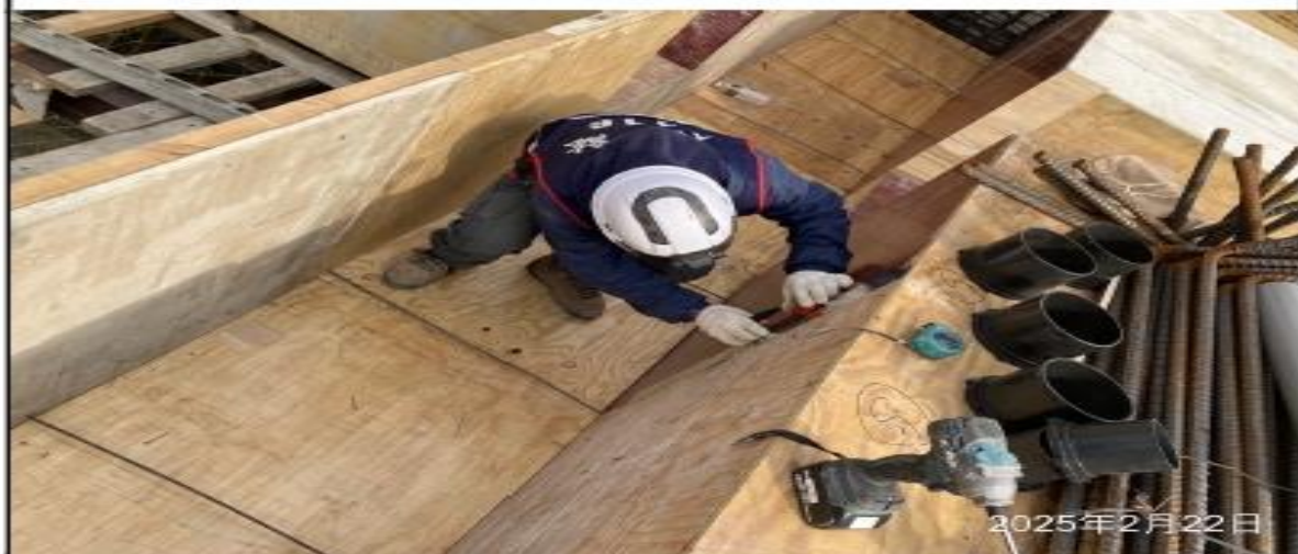
說明：B1F穿梁套管放樣。
