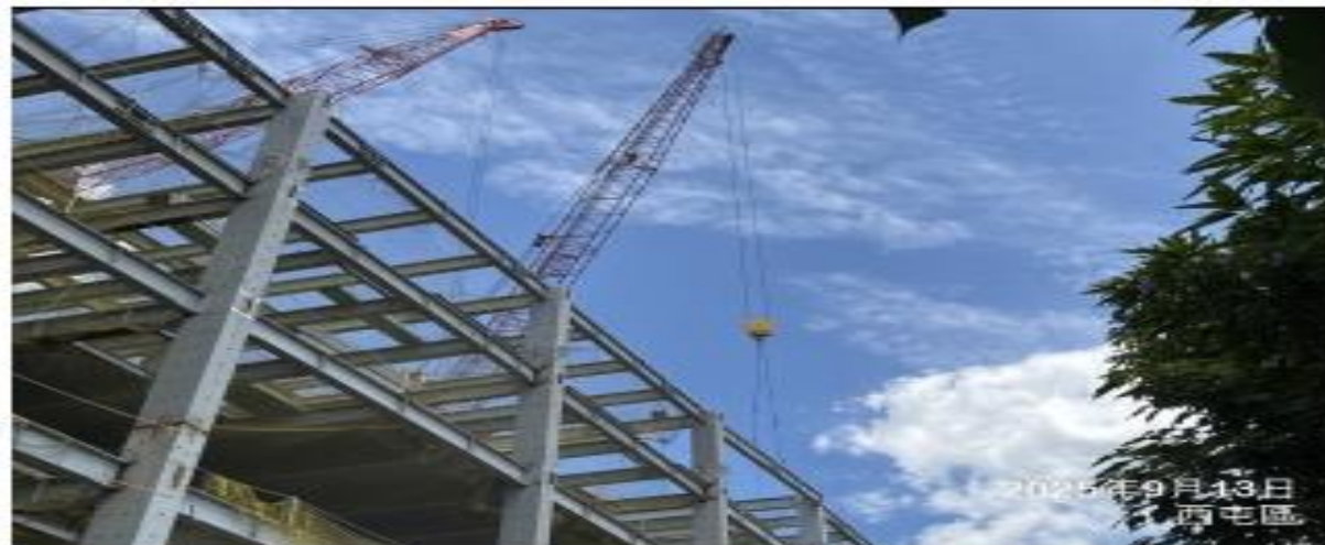
說明：鋼構吊裝作業。
