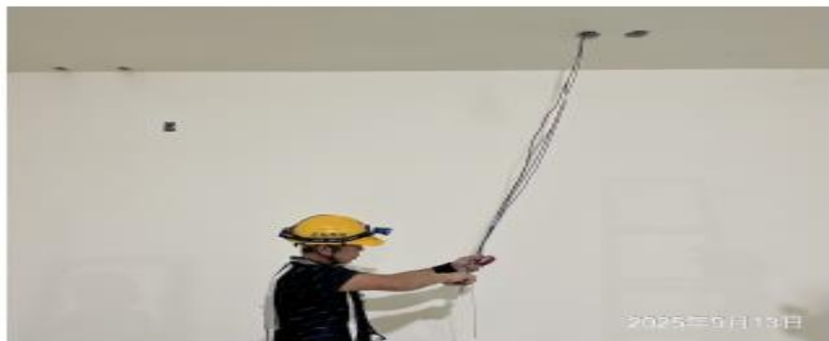
說明：地下室拉線作業。
