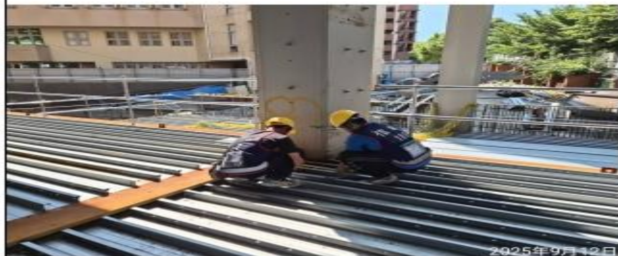
說明：預埋管路配設。
