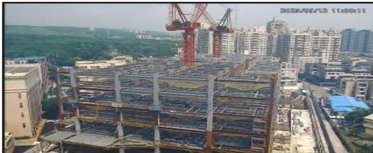
說明：工地空拍照。
