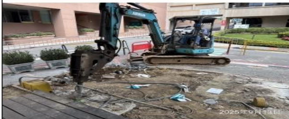
說明：收費機處試挖。
