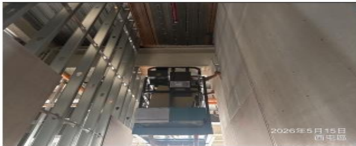
說明：輕隔間封板。
