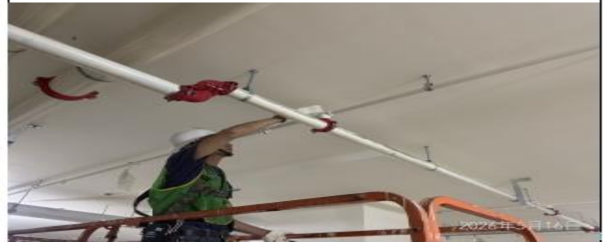
說明：消防管路補漆。
