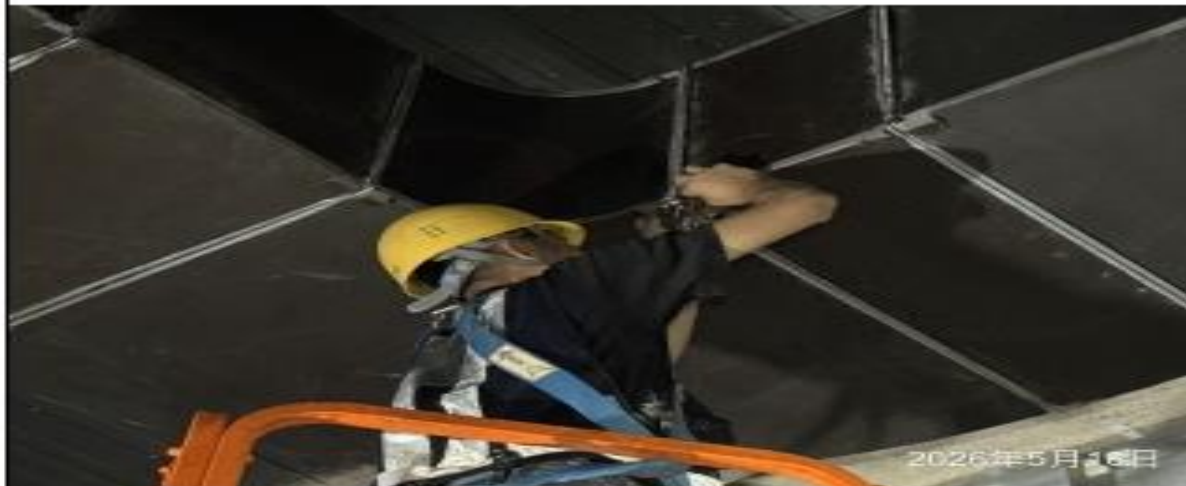
說明：空調風管安裝。
