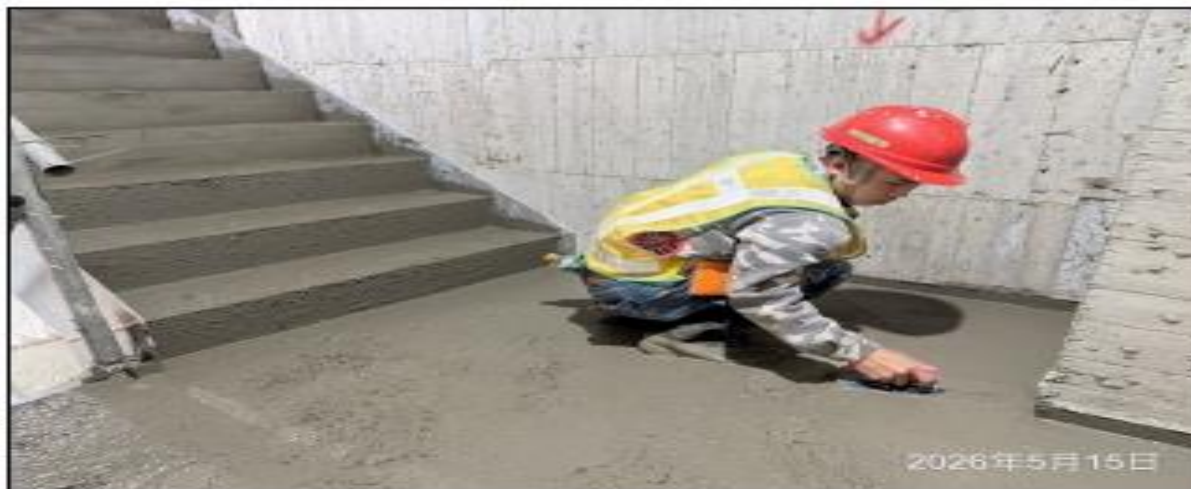
說明：樓梯混凝土澆置。
