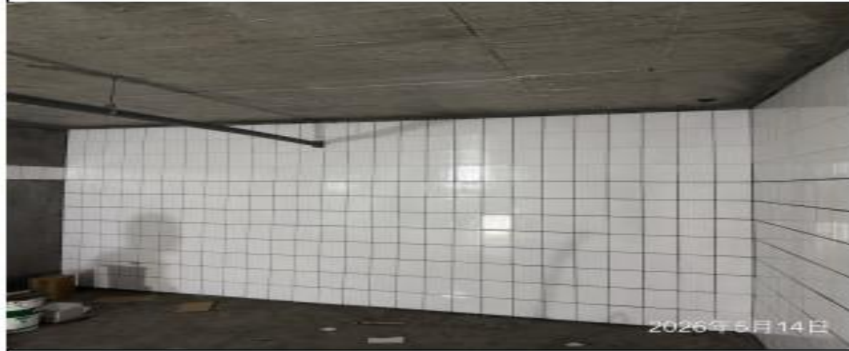
說明：筏基雜用水箱貼磚。
