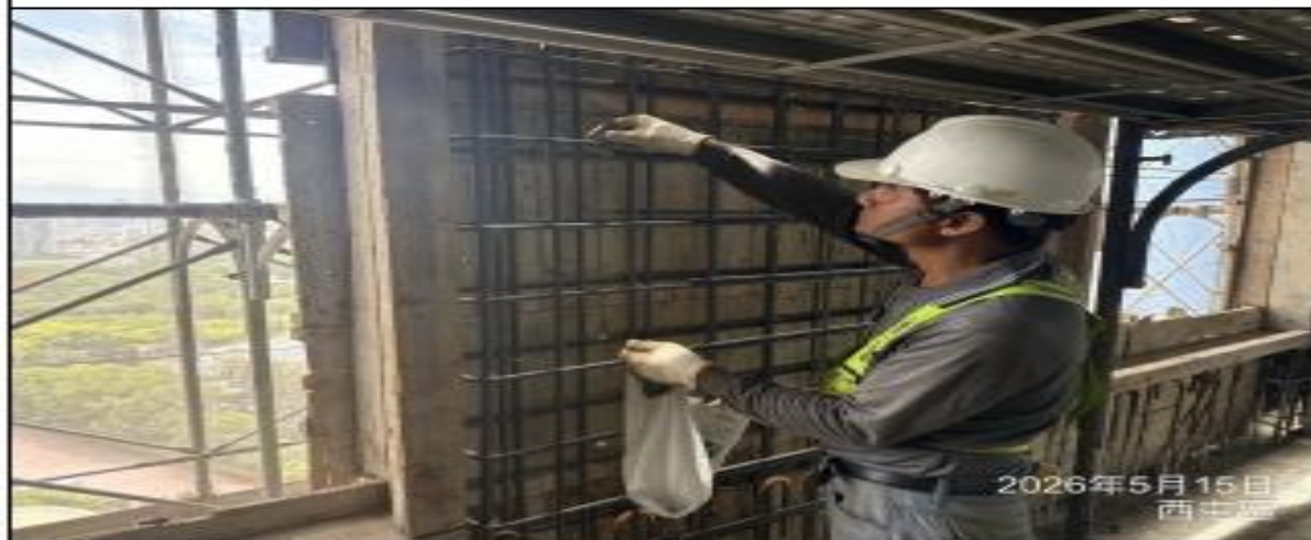
說明：鋼筋間隔器安裝。
