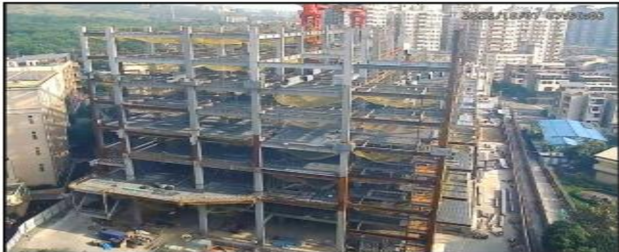
說明：工地空拍照。
