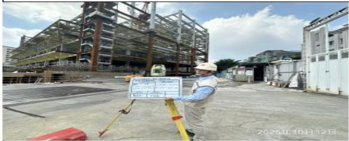
說明：鋼構柱位校正施工抽查。
