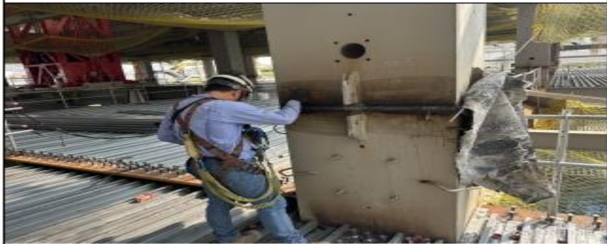
說明：鋼構柱對接UT檢測。
