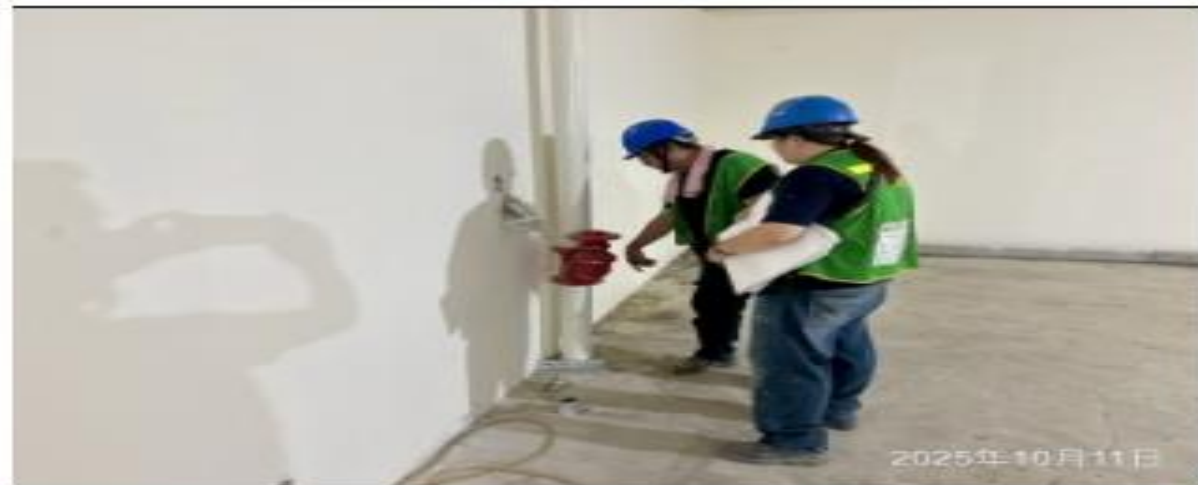
說明：消防管路配管。
