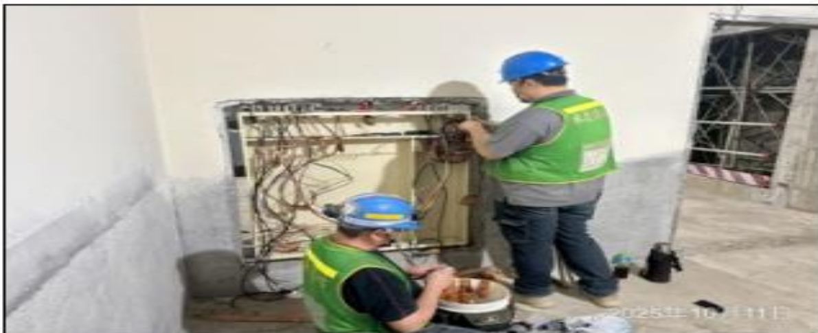
說明：消防拉線作業。
