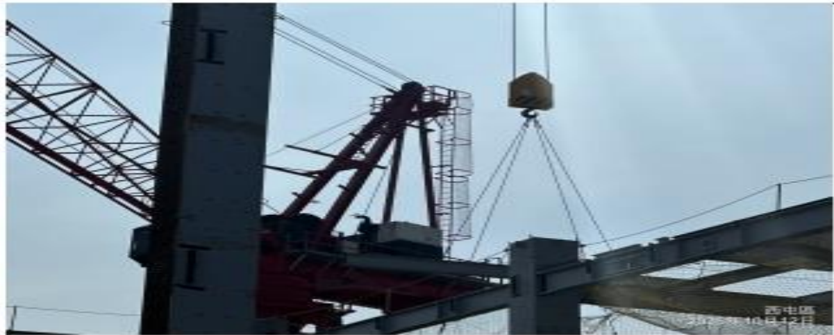
說明：鋼構吊裝作業。
