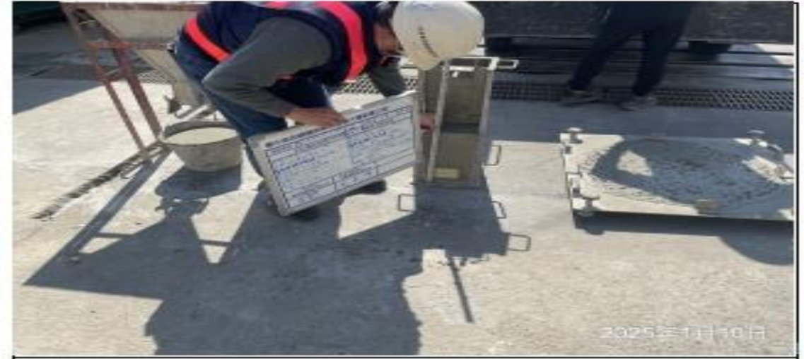
說明：柱內混凝土澆置-坍流度.V型及箱型等試驗。
