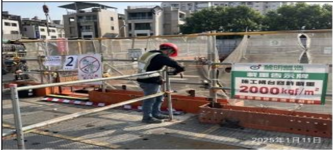
說明：職安設施-欄杆施作。
