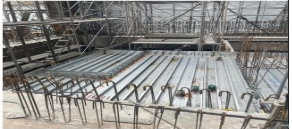
說明：B2FL 鋼承板施作。
