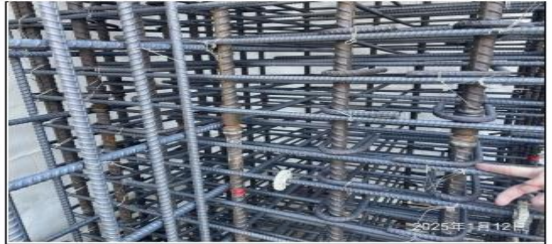
說明：B2F柱鋼筋綁紮。
