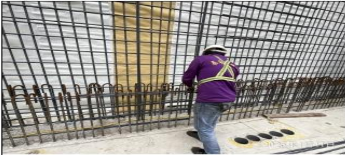
說明：B2F外牆鋼筋綁紮。
