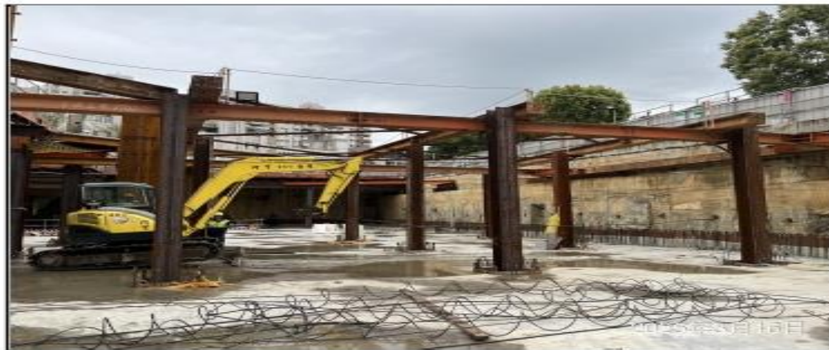
說明：東側、西側第一層地錨拆除。
