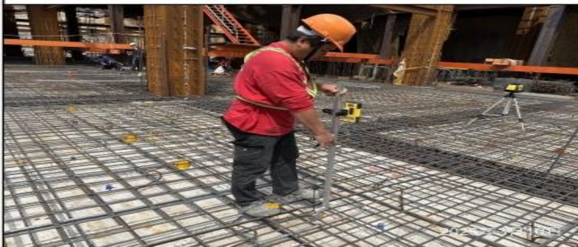
說明：B1FL混凝土澆置前高程標高。
