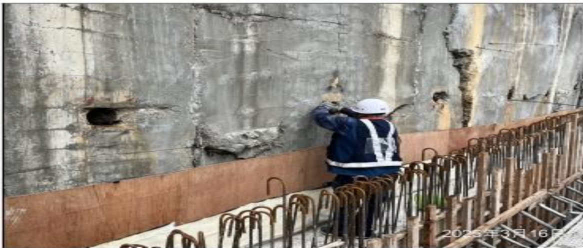
說明：東側、西側第一層地錨拆除。
