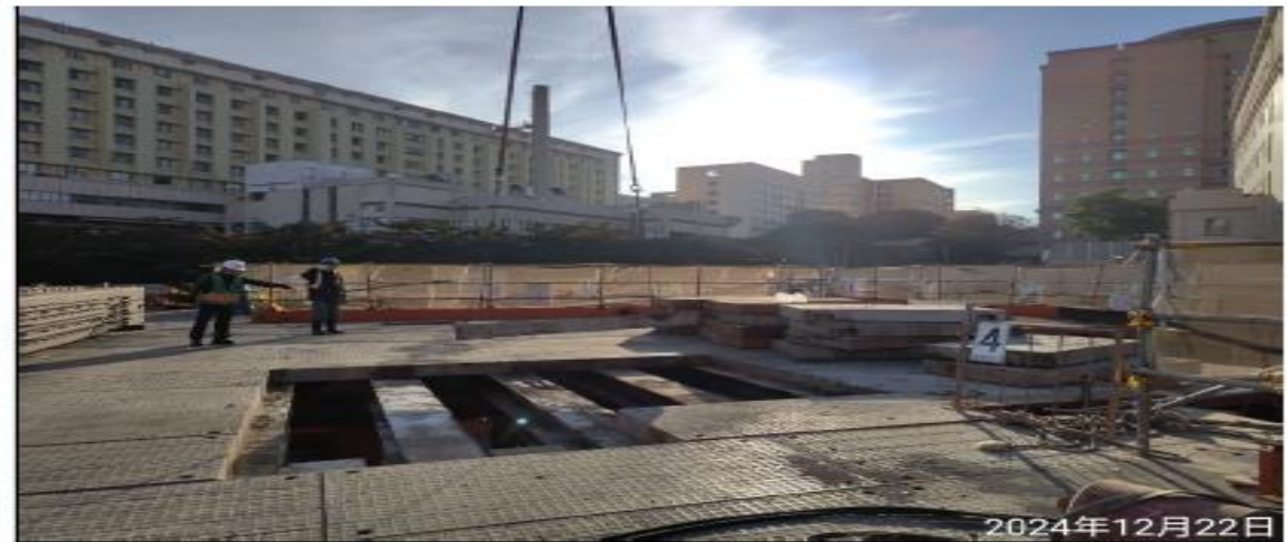
說明：配合鋼構吊裝拆裝構台。
