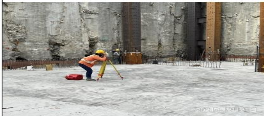
說明：鋼構第三節Line1~3柱位校正。
