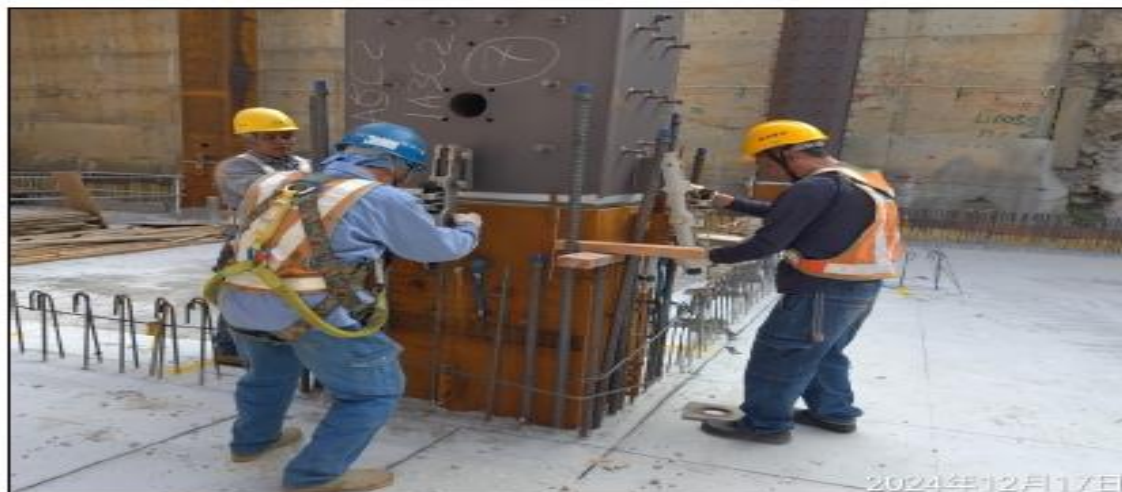
說明：鋼構第三節柱梁吊裝。
