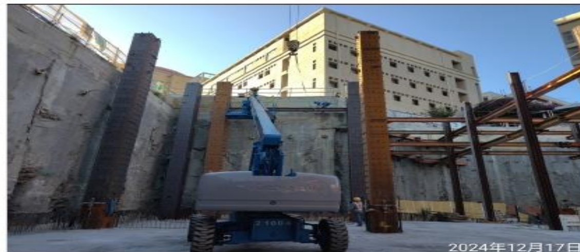
說明：鋼構第三節柱梁吊裝。
