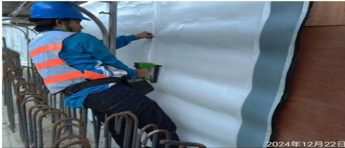
說明：B2FL外牆防水膜施作。
