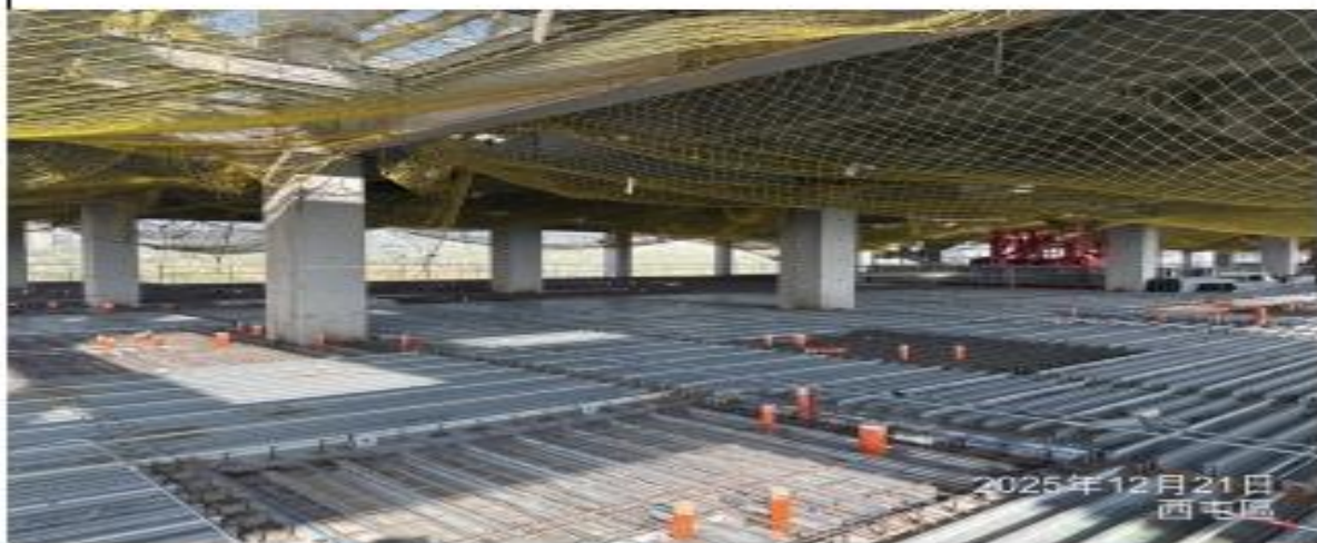
說明：鋼線網鋪設。
