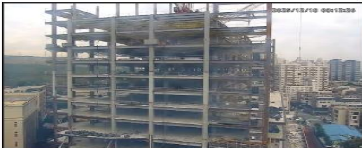
說明：工地空拍照。
