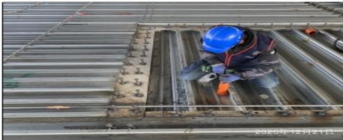
說明：預埋套管安裝。
