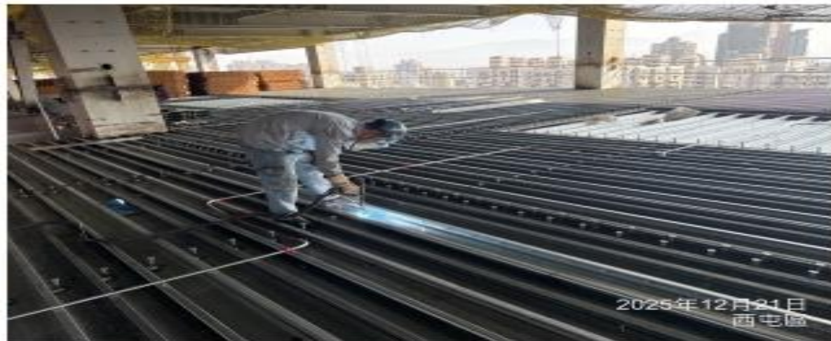
說明：鋼承板鋪設。
