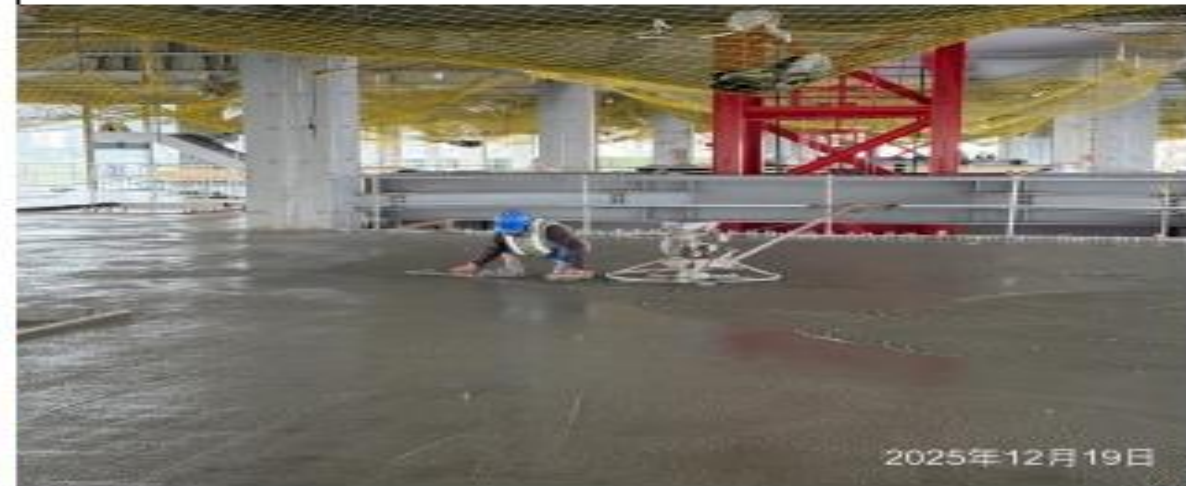
說明：樓版混凝土澆置及粉光作業。
