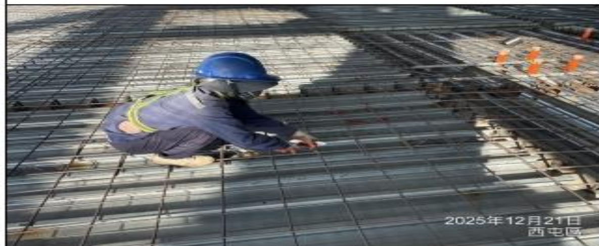
說明：鋼線網鋪設。
