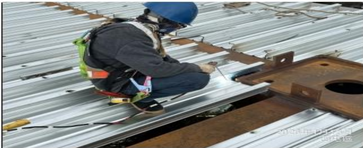
說明：鋼承鋁設置。
