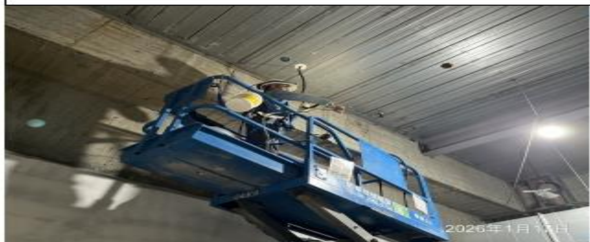
說明：管路拉線作業。
