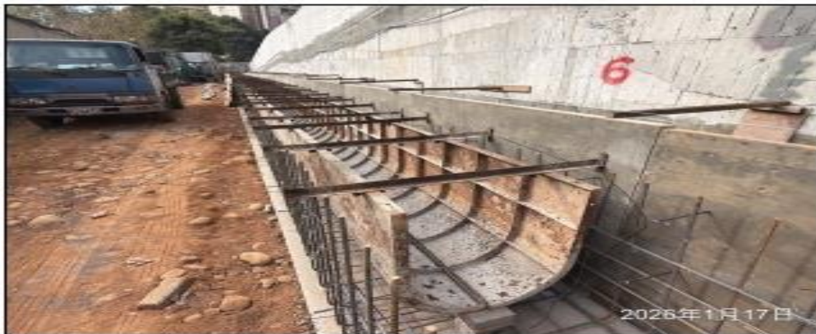
說明：東側U1溝模板組立。
