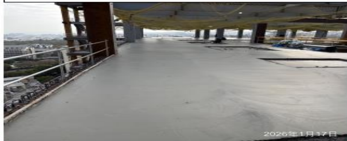
說明：12FL 混凝土澆置及粉光作業。
