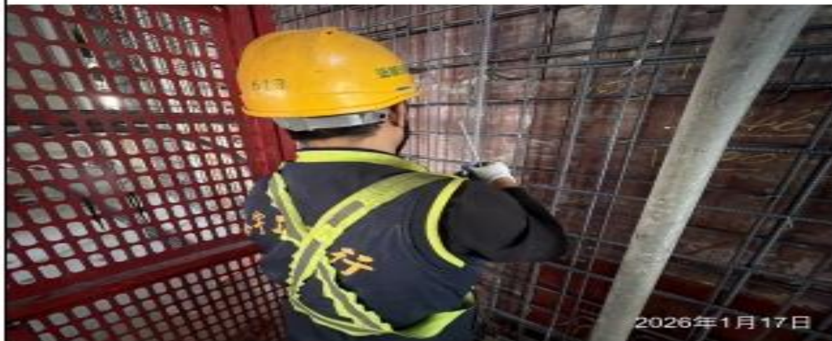
說明：牆筋綁紮。
