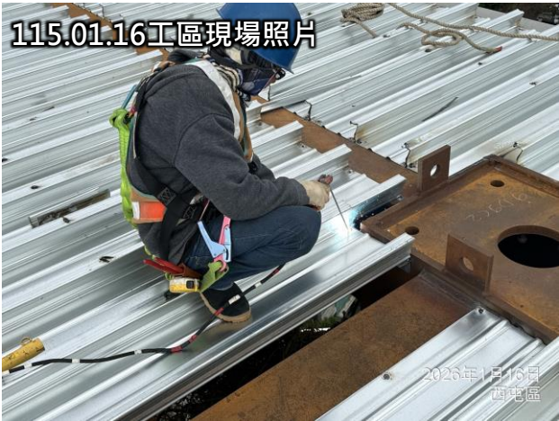
115.01.17工區現場照片
