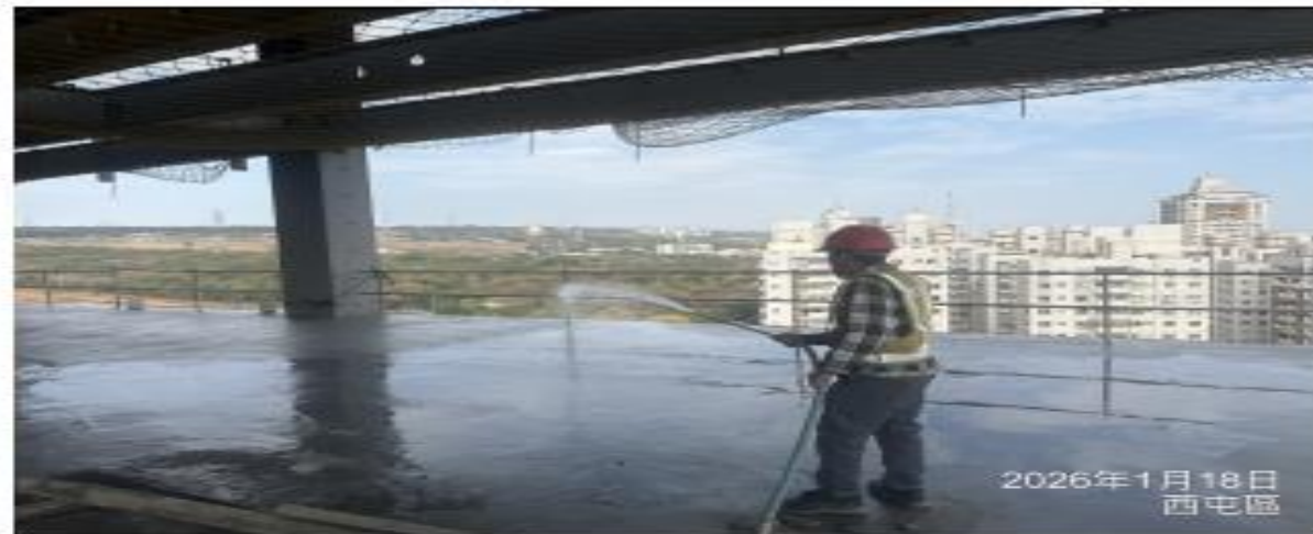
說明：樓版養護作業。
