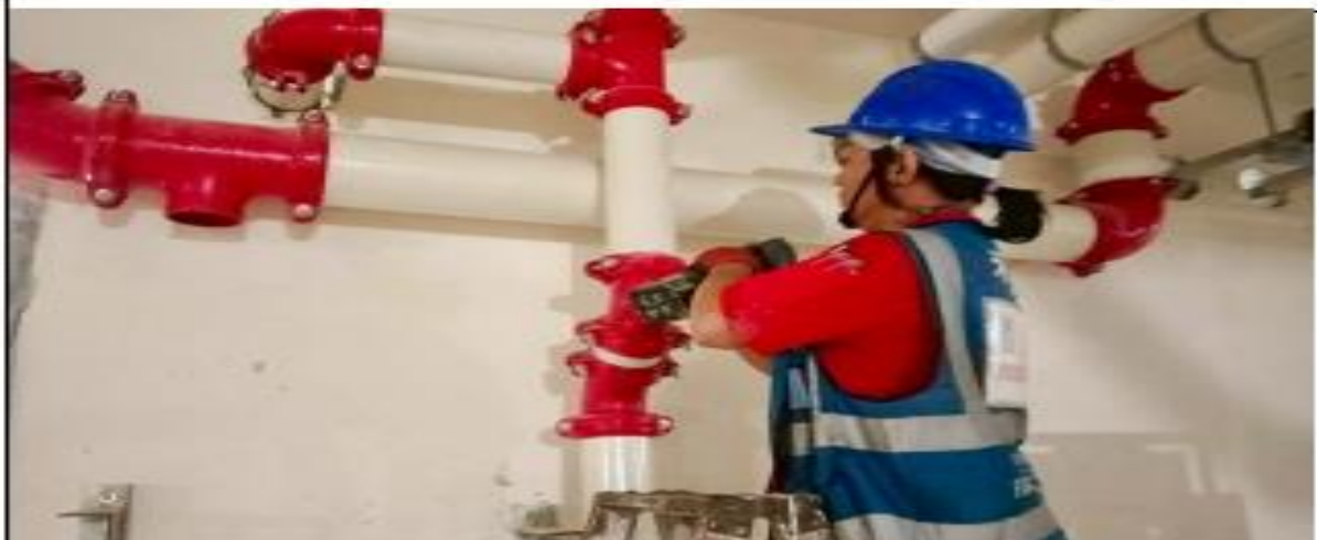
說明：B2F-1F水源幹管配管。
