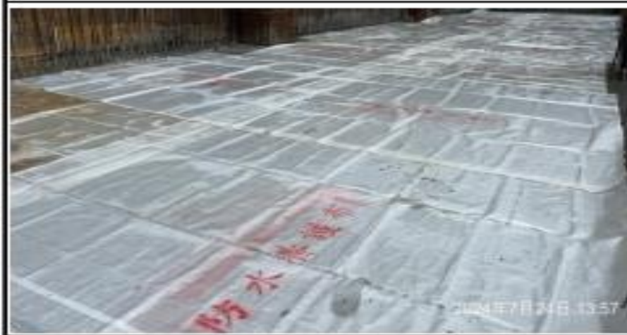
說明：工區防汛應變處置。
