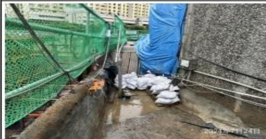
說明：工區防汛應變處置。
