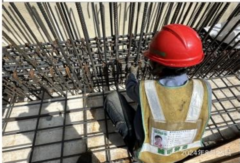
說明：鋼筋綁紮。
