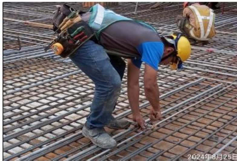
說明：電力系統B4FL樓版預埋管路配管。
