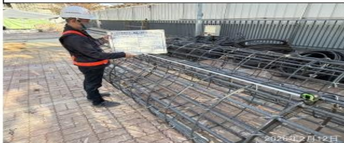
說明：P1D、P1E 基樁鋼筋籠施工抽查。
