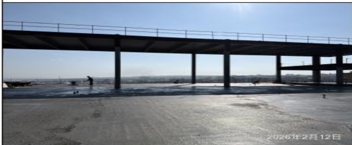
說明：13FL 混凝土澆置粉光作業。
