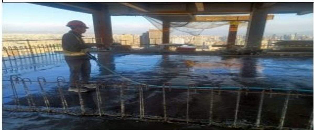
說明：13FL 樓版養護。
