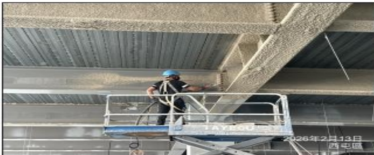
說明：防火披覆施作。
