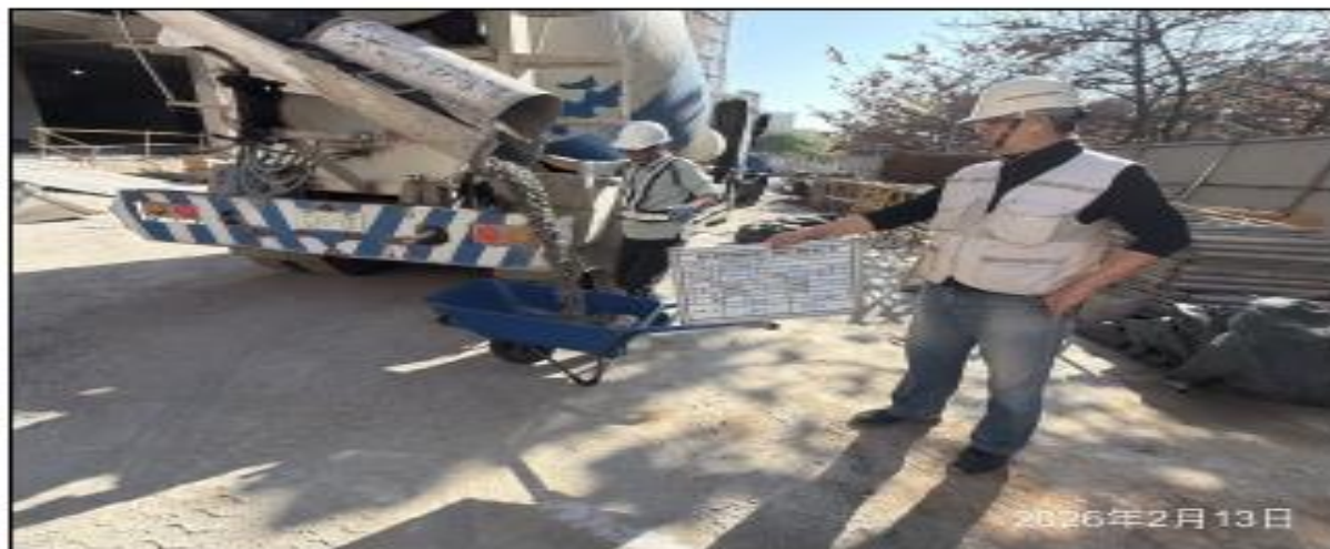
說明：P1D、P1E基樁混凝土澆置取樣。
