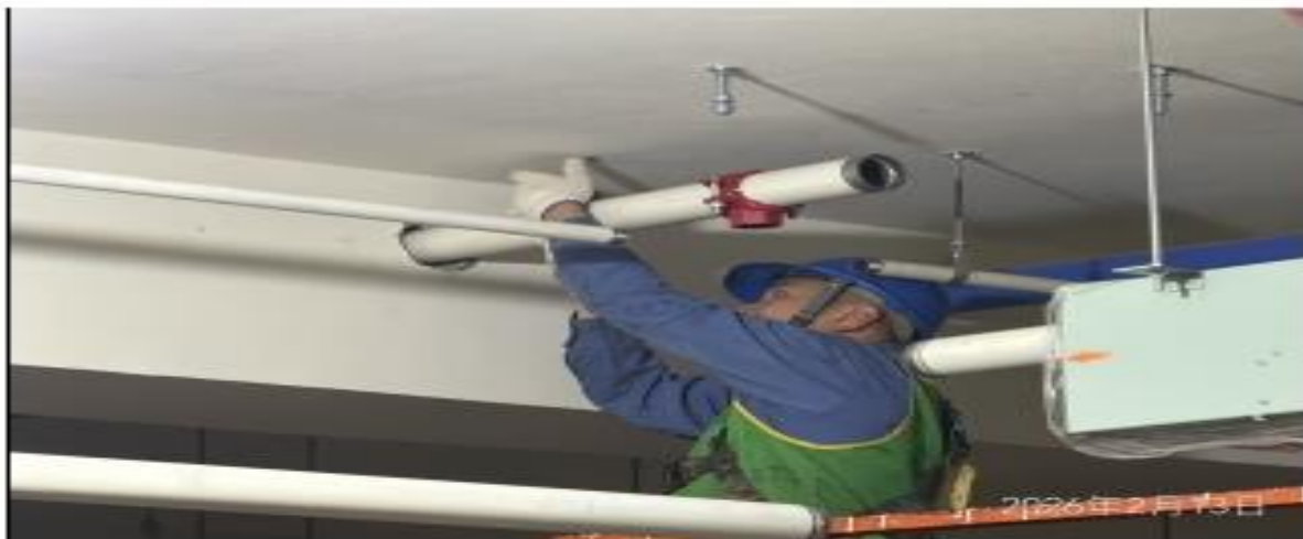
說明：消防管路配管。
