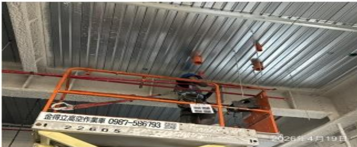
說明：消防管路配管。
