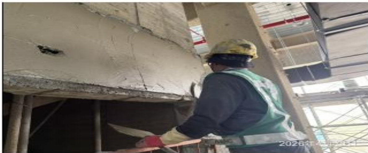
說明：泥作施作。
