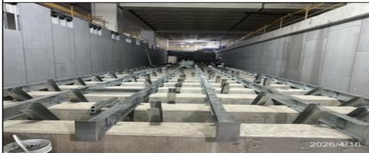
說明：水箱基礎組立。
