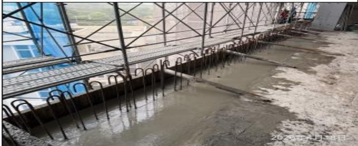
說明：混凝土澆置。
