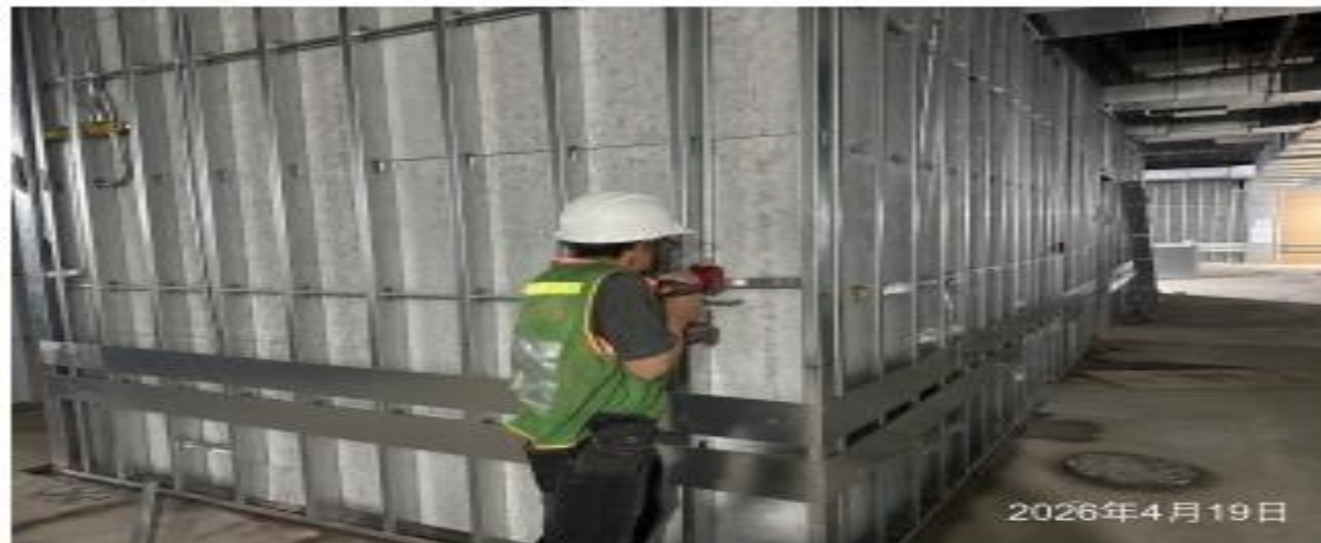
說明：輕隔間預埋管路配管。
