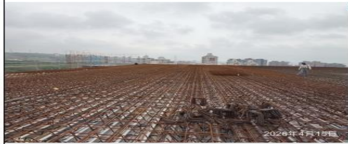
說明：鋼筋綁紮。
