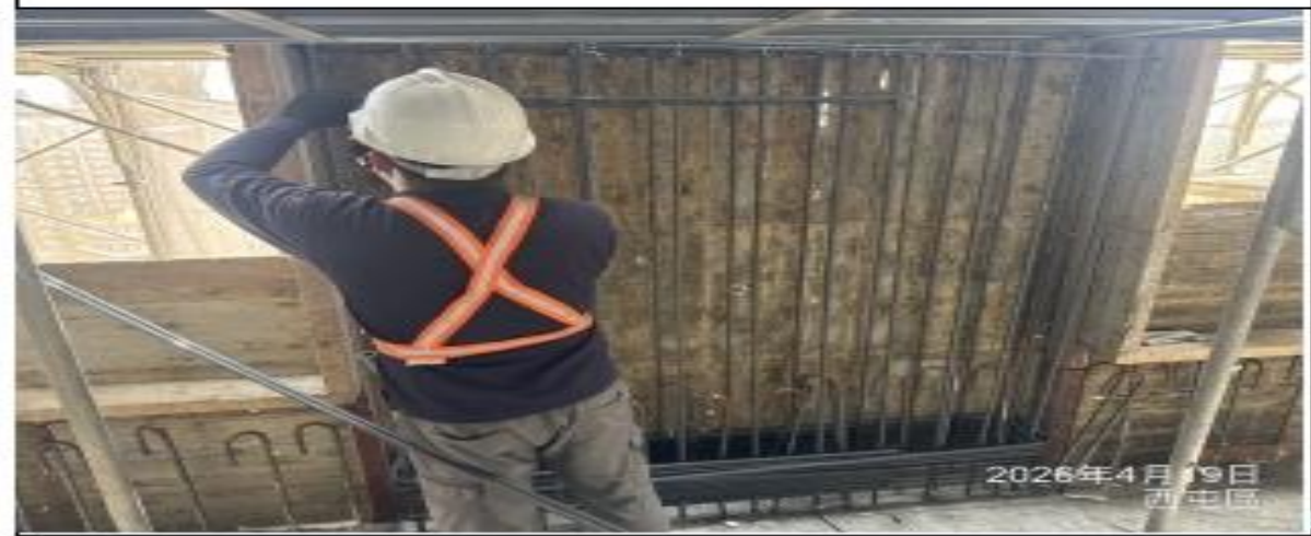
說明：牆面鋼筋綁紮。
