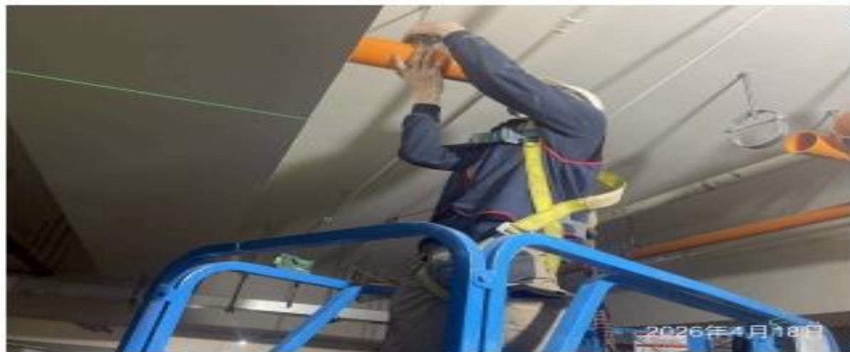
說明：排水管路施作。
