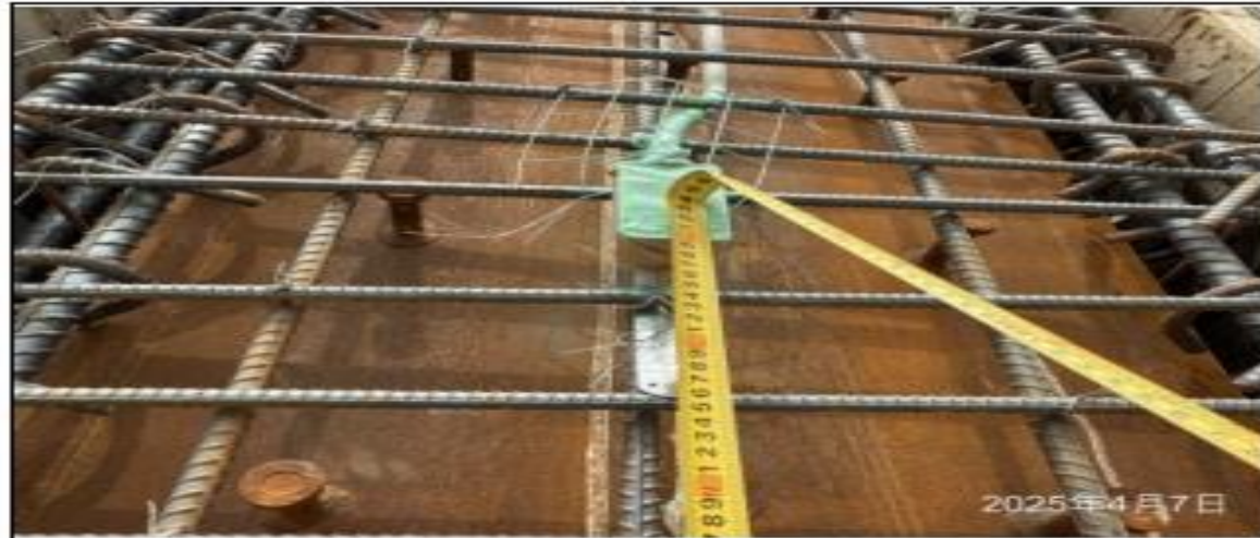
說明：B1F柱預埋管路施作。
