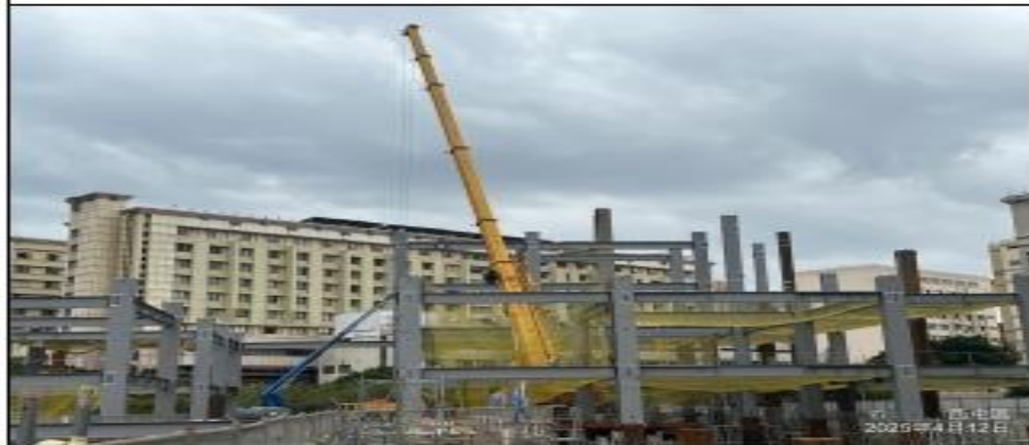
說明：第五節鋼構安裝。
