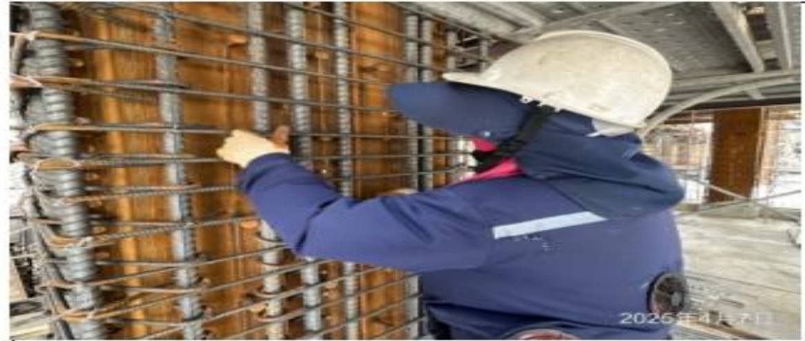
說明：B1F柱鋼筋綁紮。
