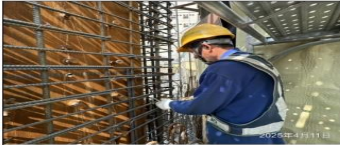
說明：B1F柱鋼筋綁紮。
