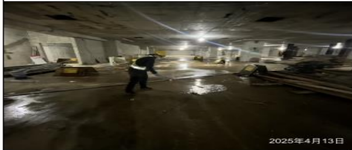
說明：地下室整理整頓。
