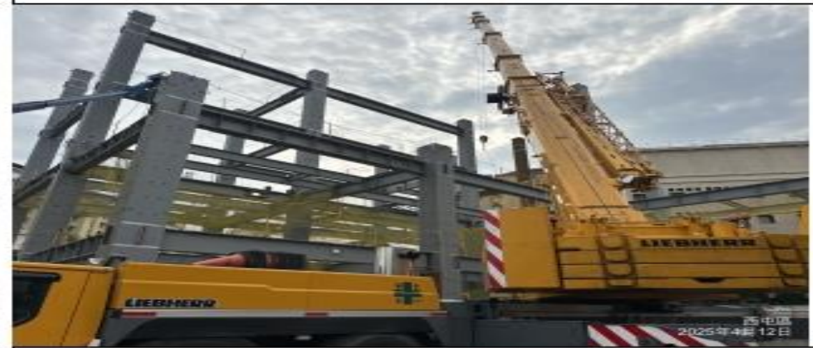
說明：第五節鋼構安裝。
