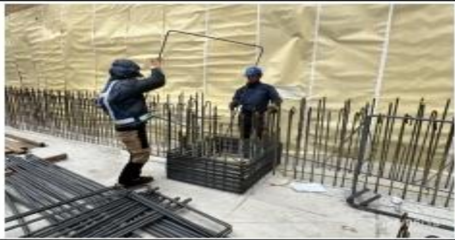
說明：鋼筋綁紮。
