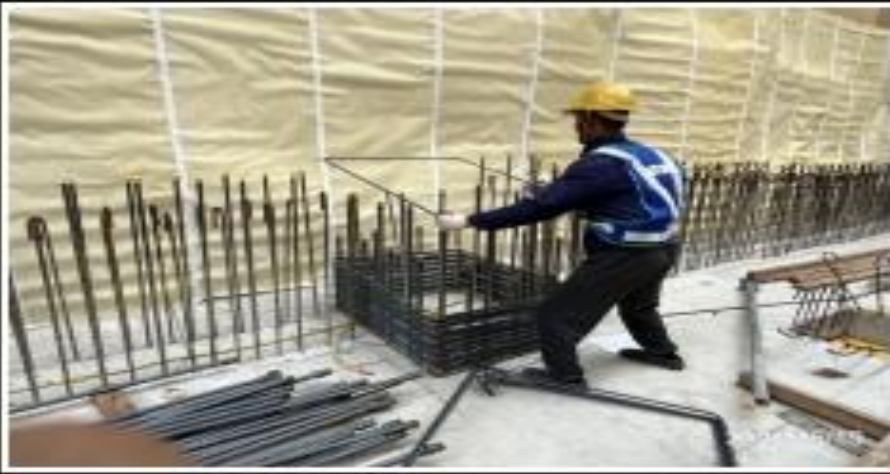
說明：鋼筋綁紮。
