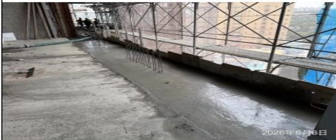
說明：混凝土澆置作業。
