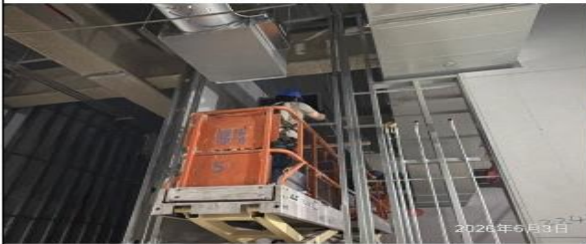
說明：空調風管安裝。
