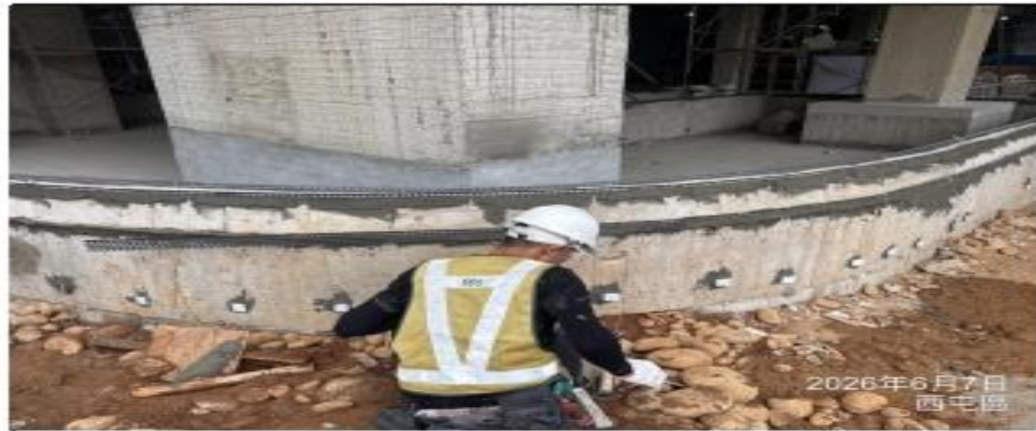
說明：泥作灰誌施作。
