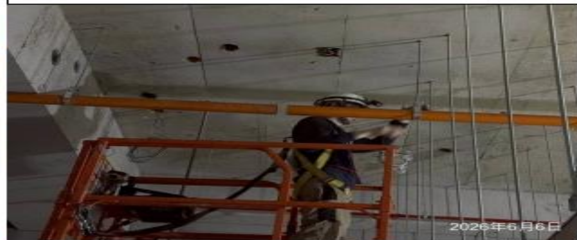
說明：排水管路安裝。
