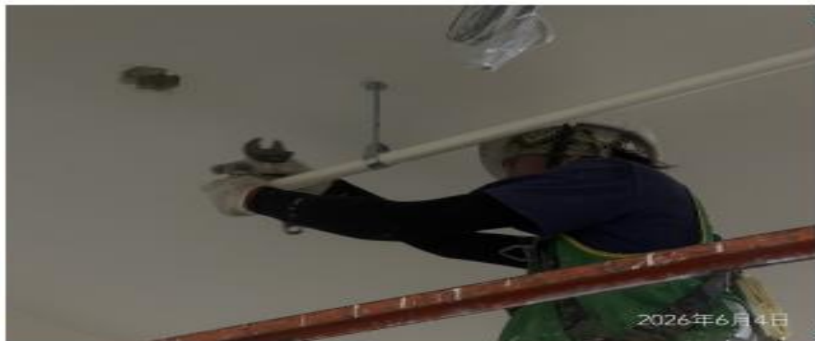
說明：消防管路接裝。
