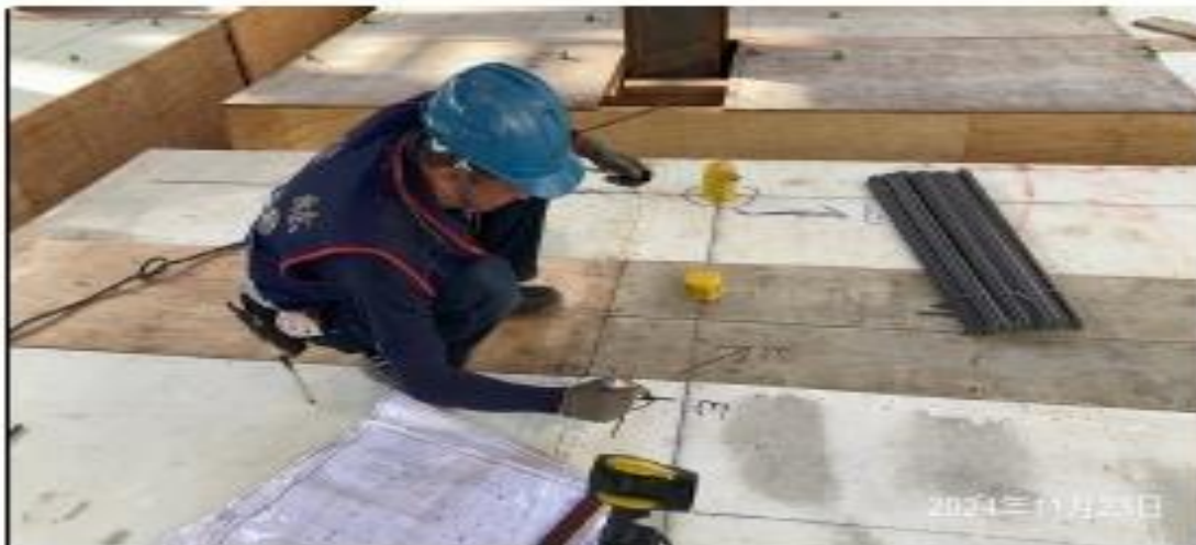
說明：B2FL樓版放樣施作。
