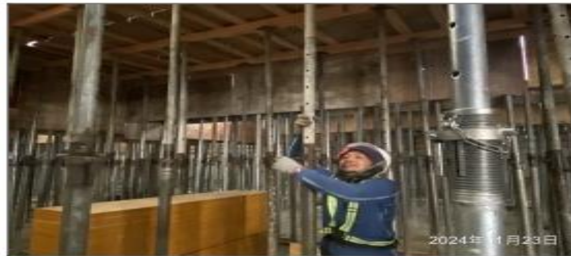
說明：B2FL梁版模板支撐。
