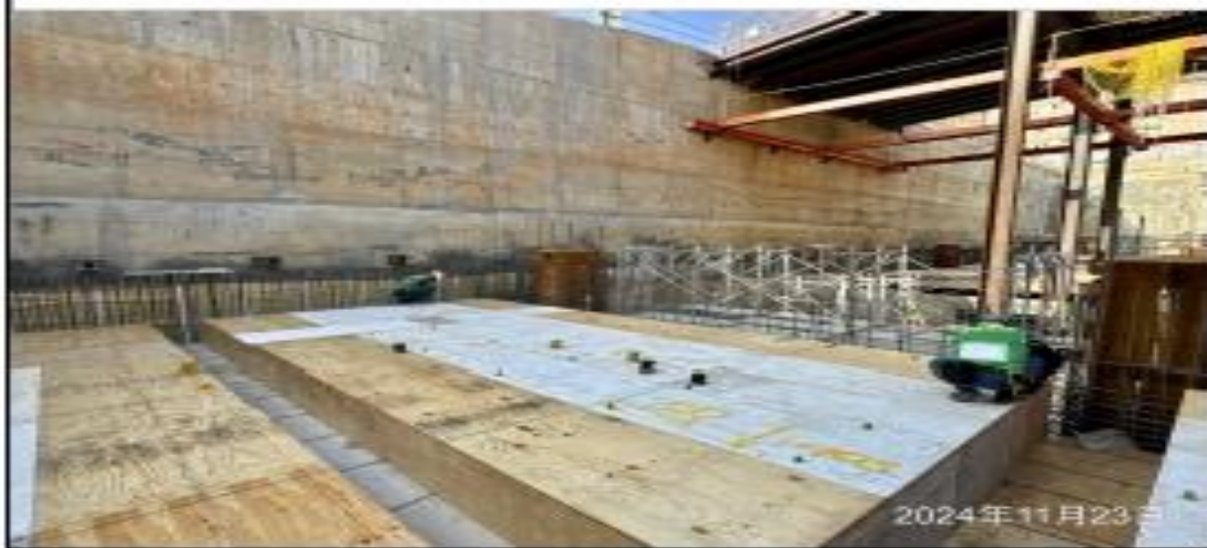
說明：B2FL樓版放樣施作。
