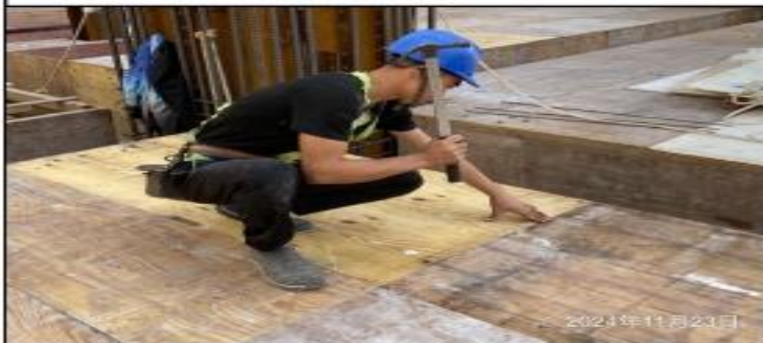
說明：B2FL樓版模板組立。
