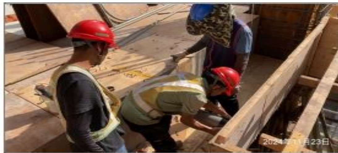
說明：B2FL穿梁套管施作。
