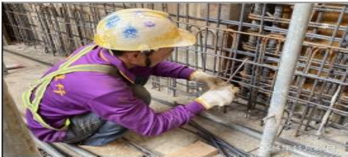
說明：B3F 2區內牆鋼筋綁紮。
