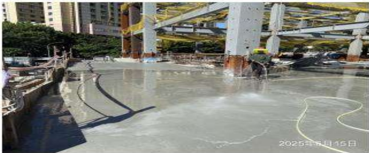
說明：1FL樓版養護。
