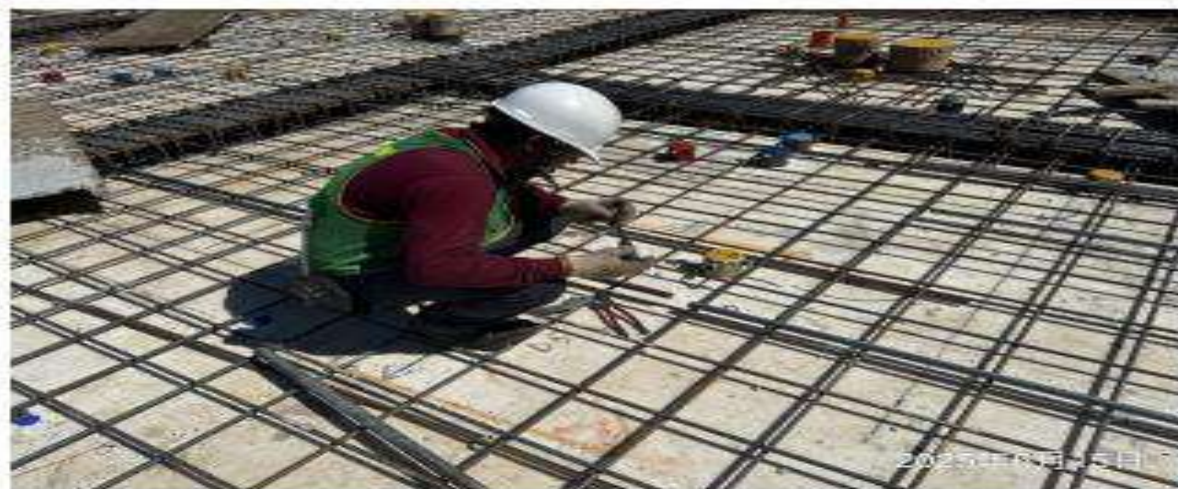
說明：1FL樓版預埋配管施作。
