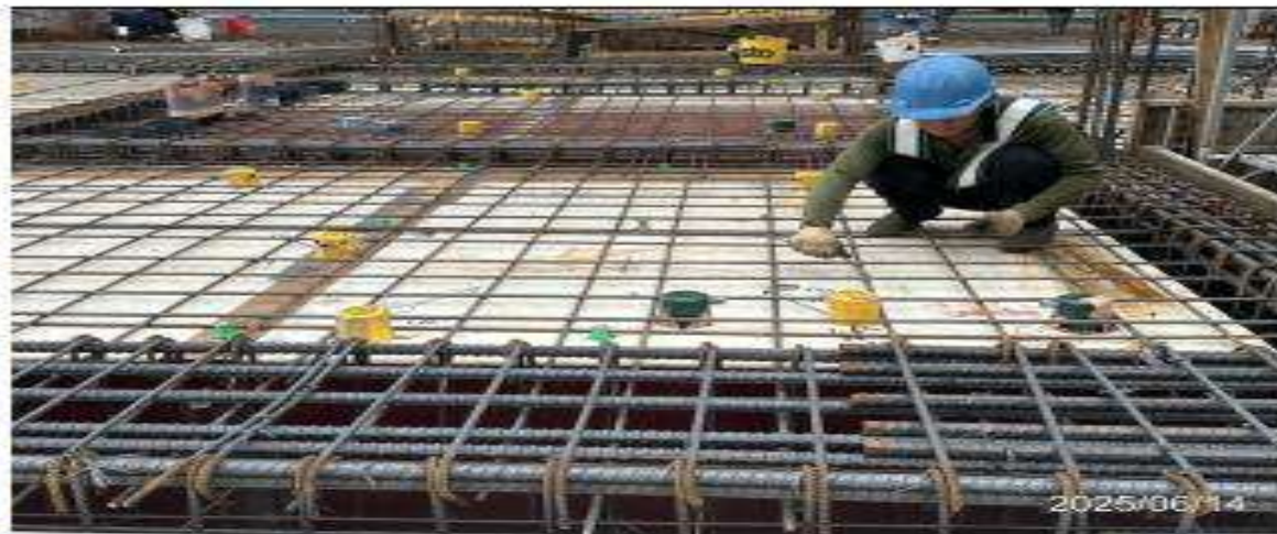
說明：1FL樓版鋼筋綁紮。
