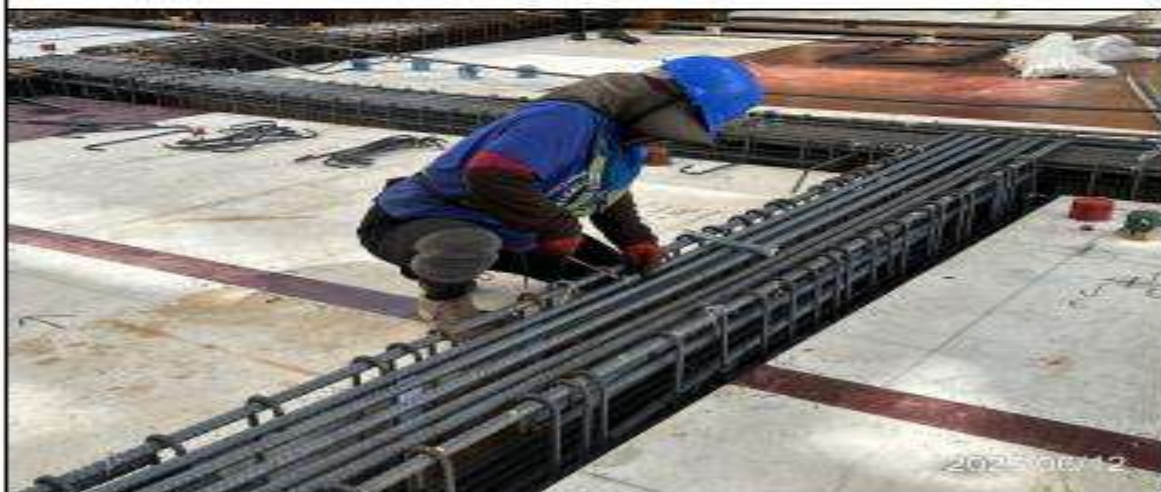
說明：1FL梁鋼筋綁紮。
