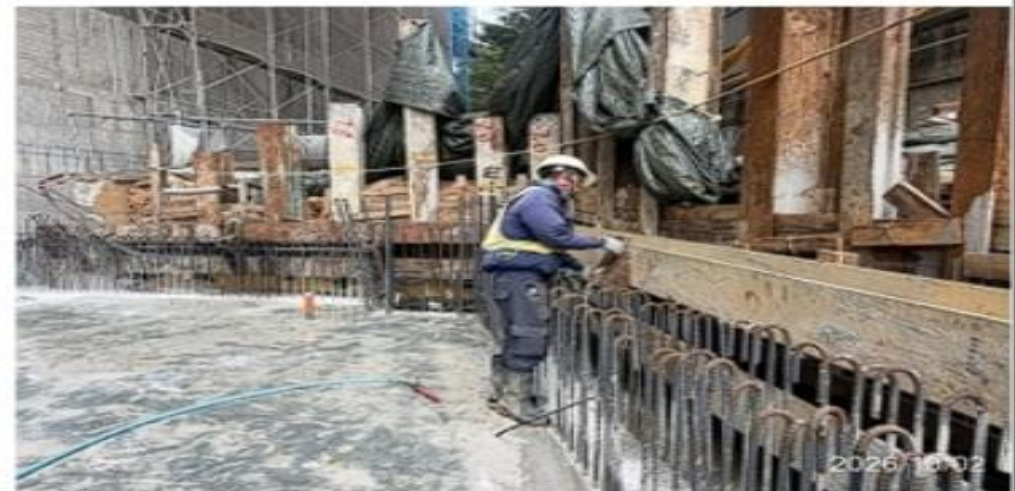
說明：外廓區橫擋拆除。
