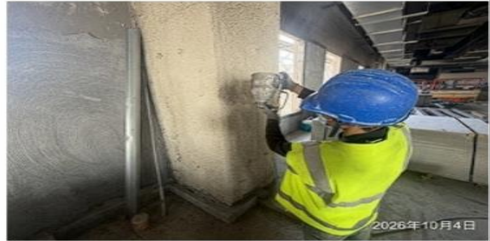
說明：4F~5F 防火披覆修補。
