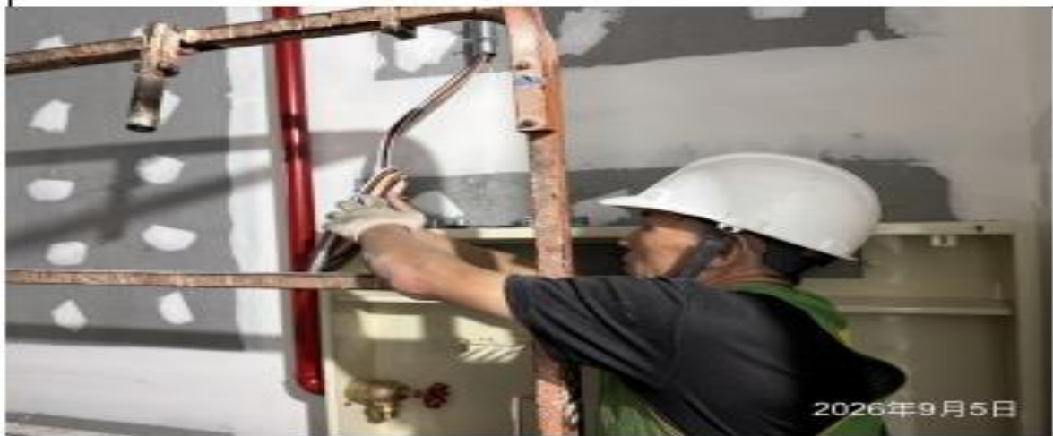
說明：消防電線拉設。
