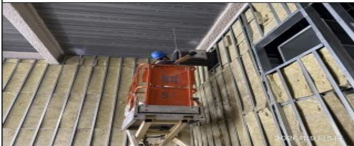
說明：風管安裝。
