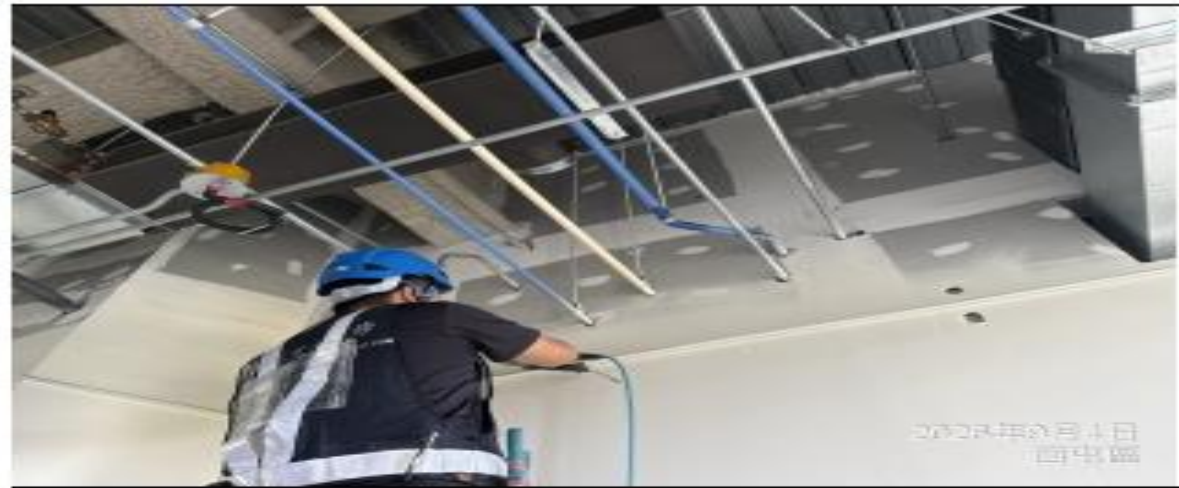
說明：ICU樣品間天花板安裝。
