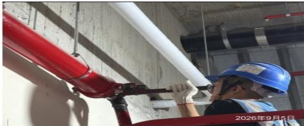
說明：消防管路安裝。
