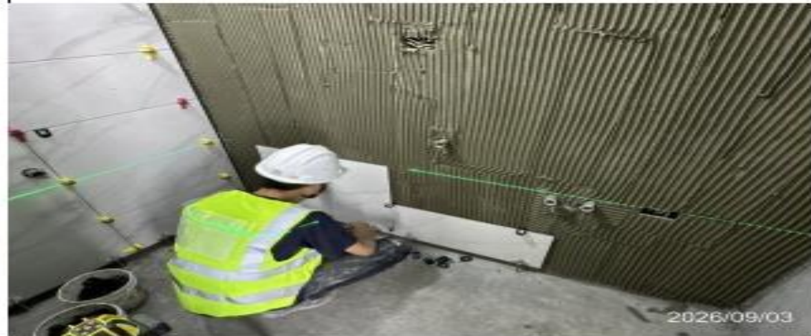
說明：ICU樣品間廁所磁磚施作。
