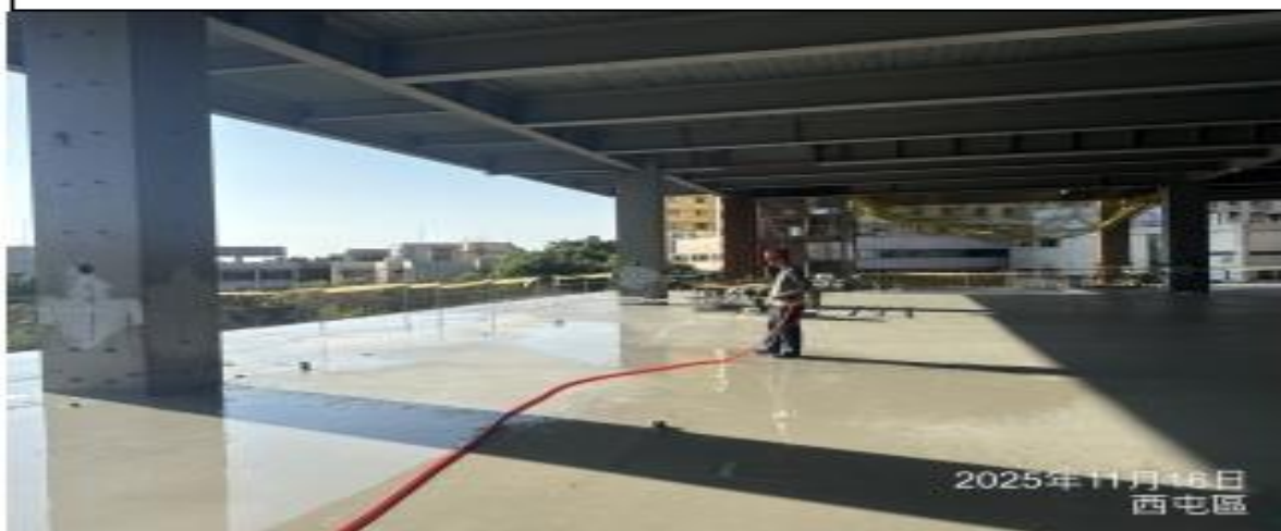
說明：3FL樓版養護。
