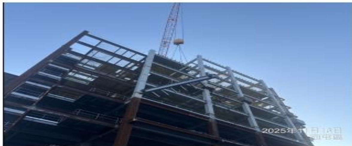
說明：鋼構吊裝。
