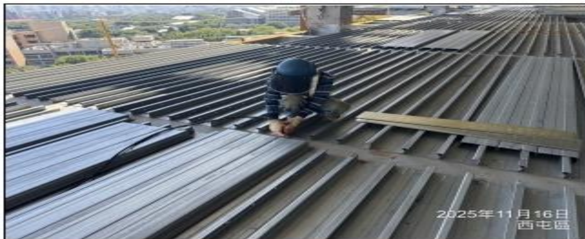
說明：鋼承板鋪設。
