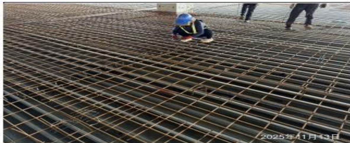
說明：鋼線網鋪設。
