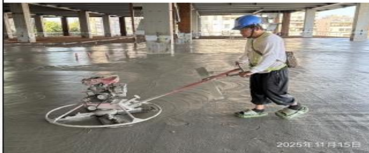
說明：3FL混凝土澆置及粉光作業。
