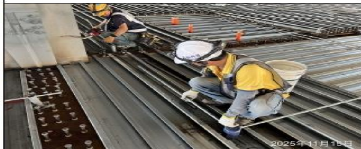
說明：預埋管路設置。
