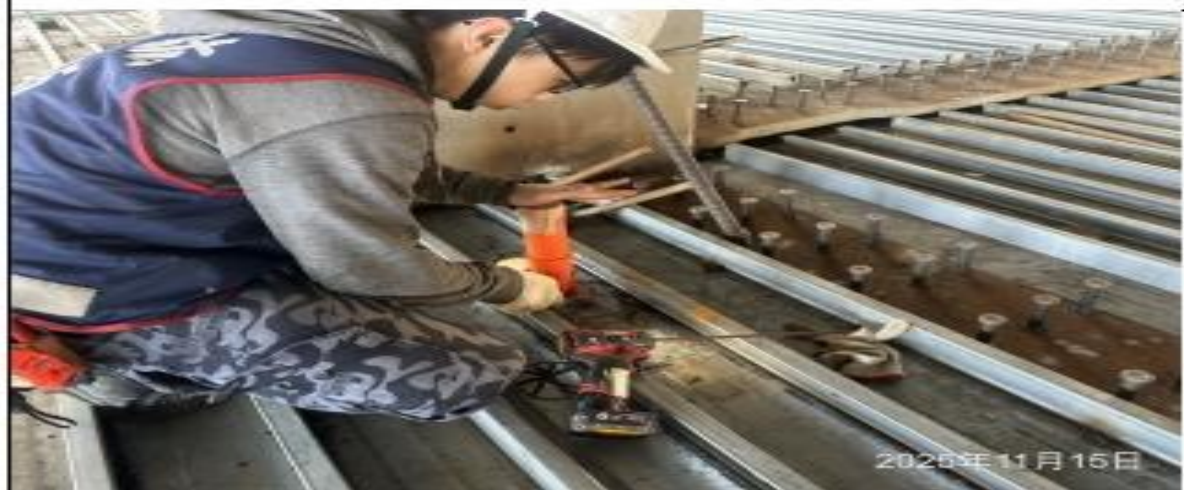
說明：預埋套管施作。
