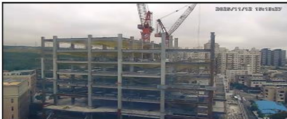
說明：工地空拍照。
