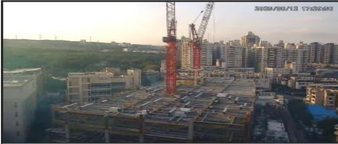
說明：工地空拍照。
