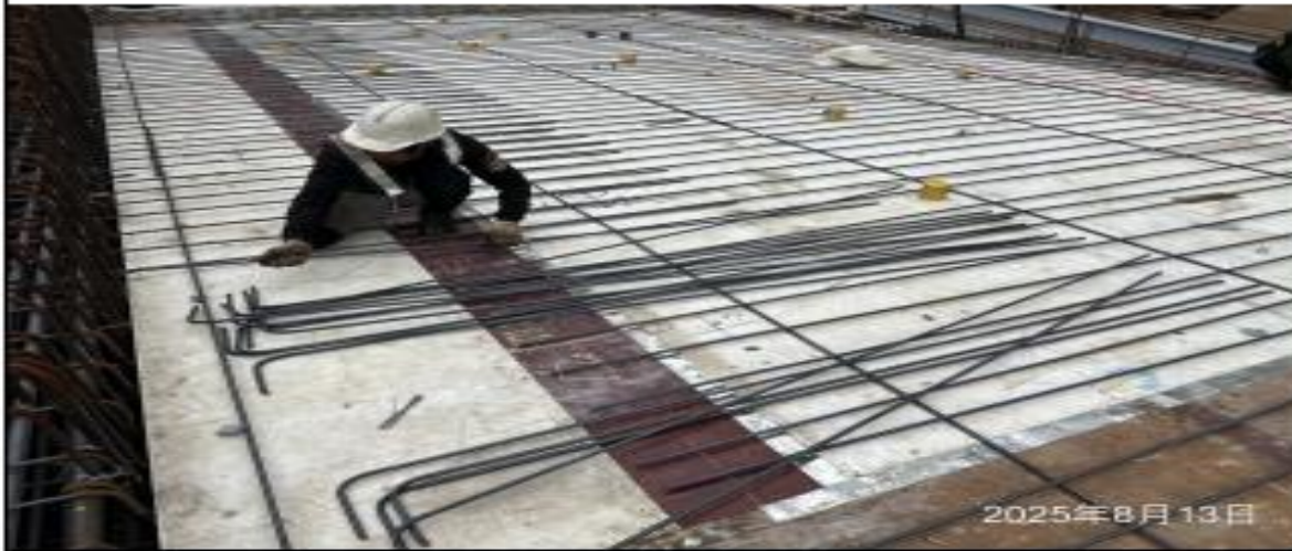
說明：1F line H,6-7車道梁版鋼筋綁紮。
