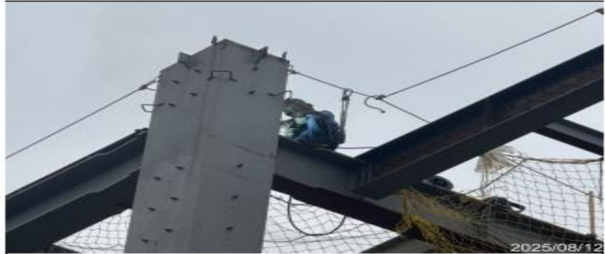
說明：鋼構焊接作業。
