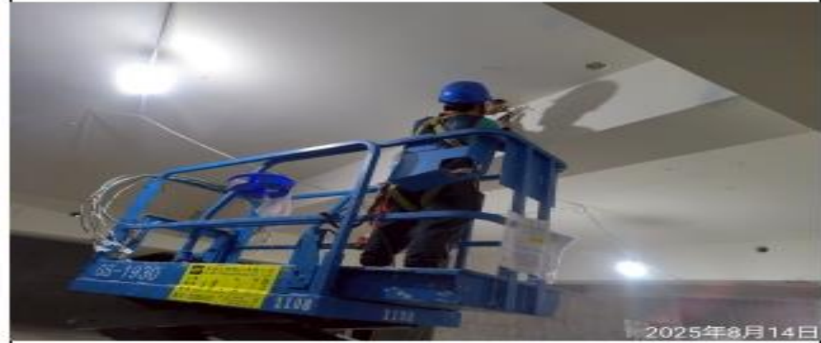
說明：地下室拉線作業。
