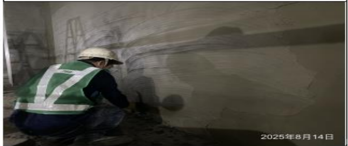
說明：地下室牆面打底粉刷。
