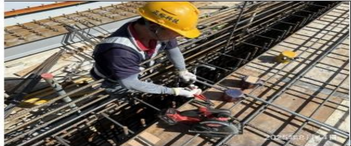
說明：1F line H,6-7車道預埋配管施作。
