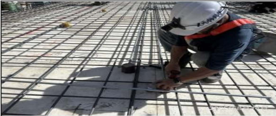
說明：1F line H,6-7車道預埋配管施作。
