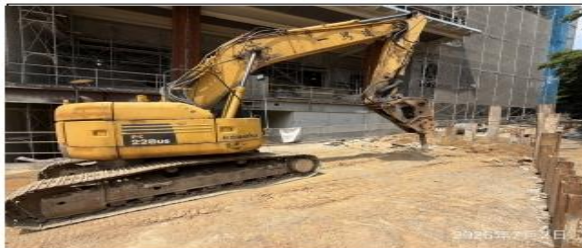
說明：第一次土方開挖之原面層破碎掘除。
