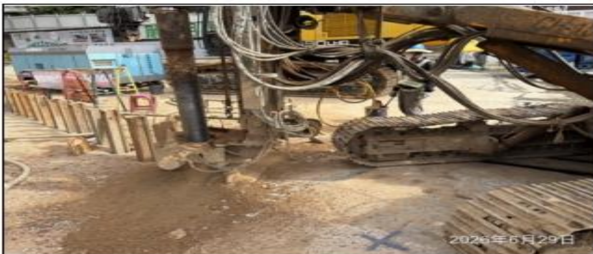
說明：擋土設施-北側擋土鋼樁施作。
