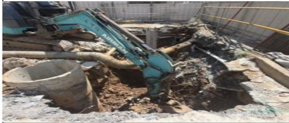
說明：空橋基礎開挖X3-1~X3-2,Y1~Y2。
