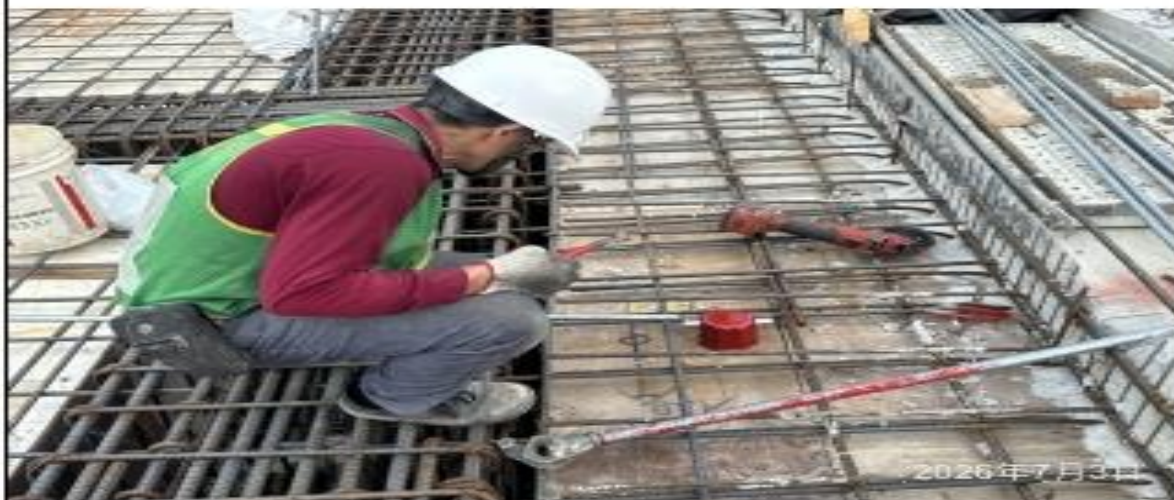
說明：預埋配管設置。
