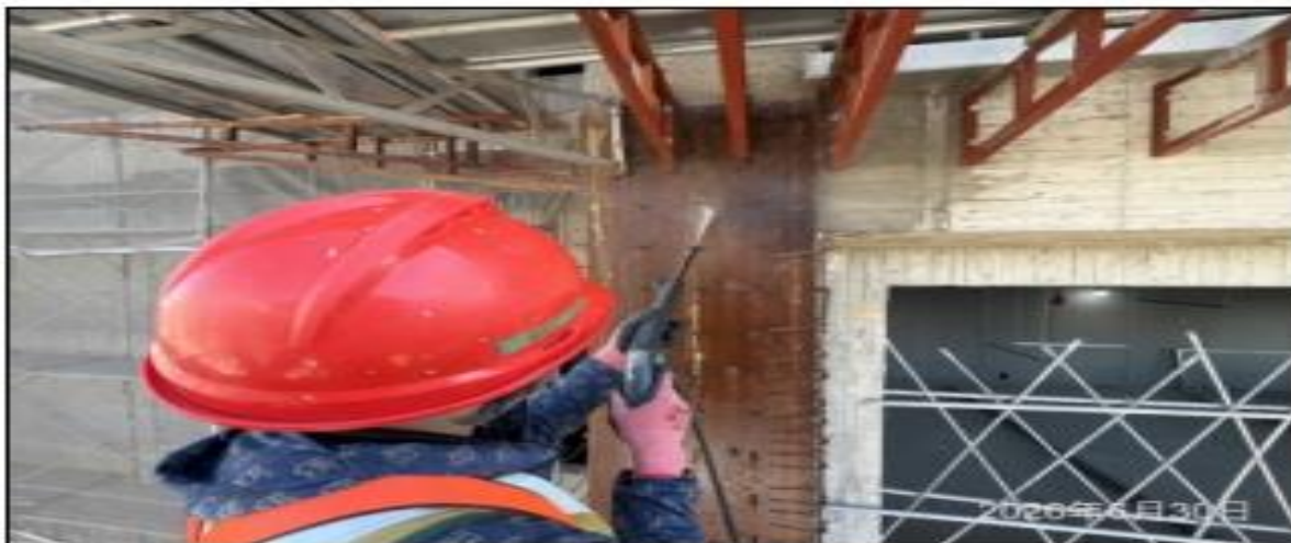
說明：鋼柱清洗。
