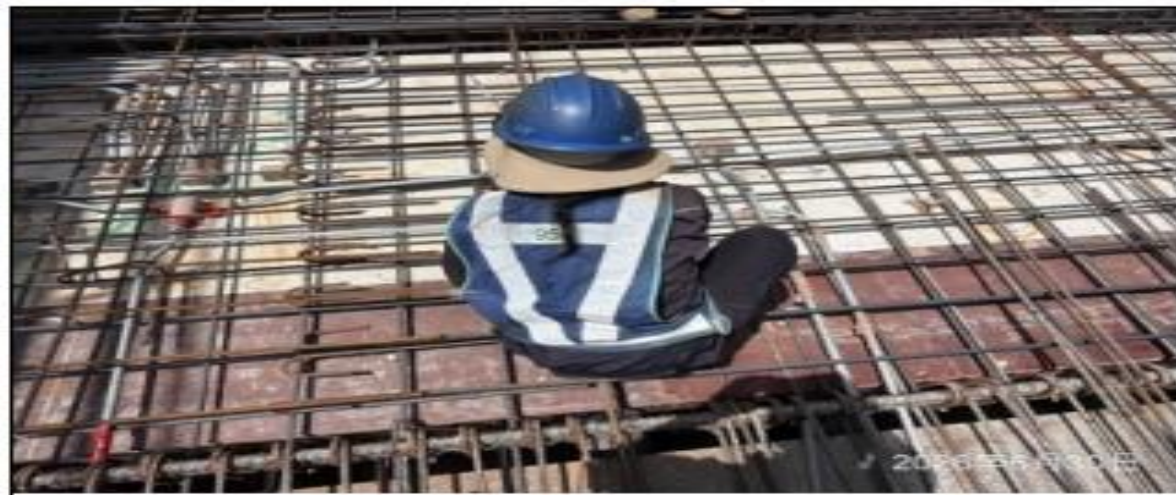
說明：鋼筋綁紮。
