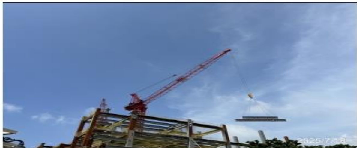
說明：B區第五節鋼梁吊裝。
