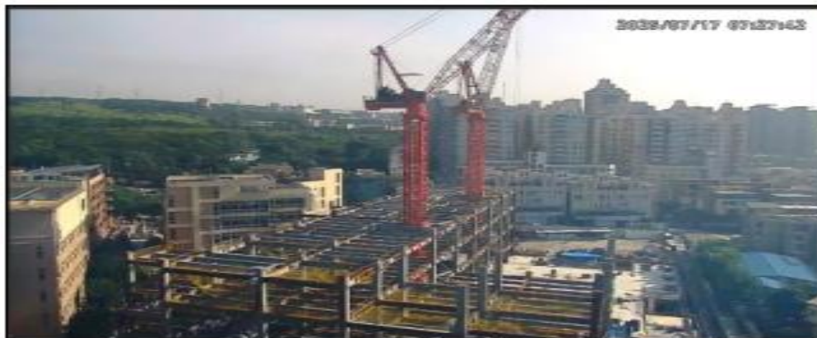
說明：工地空拍照。
