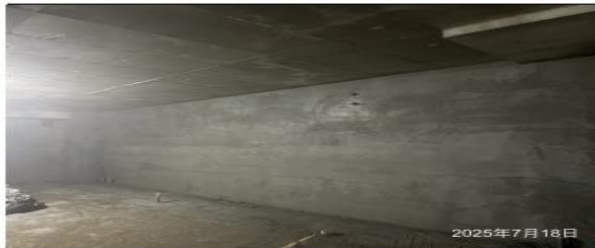
說明：B3F、B4F、B6F牆面粉刷。
