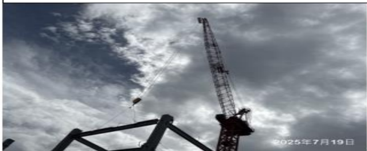
說明：B區第五節鋼梁吊裝。
