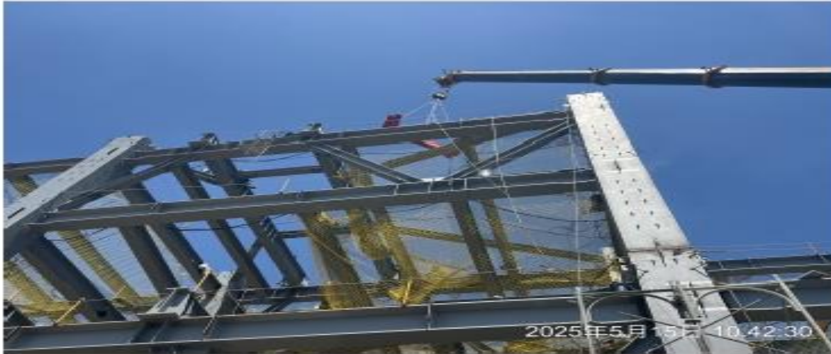
說明：塔吊組立。
