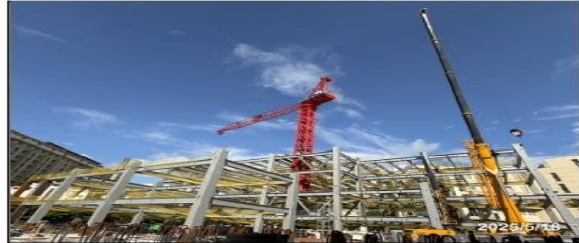
說明：塔吊組立.試車及調整。
