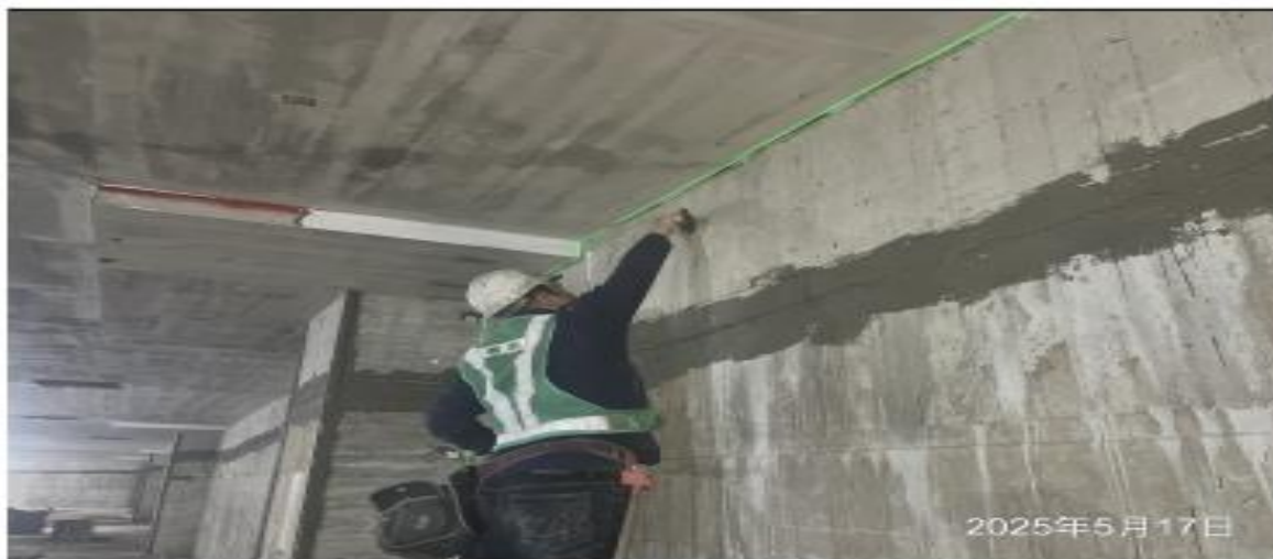
說明：B5F 北側灰誌施作。
