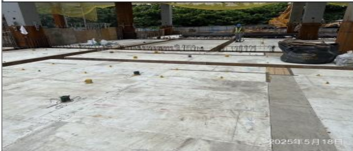
說明：1F樓版模板組立。
