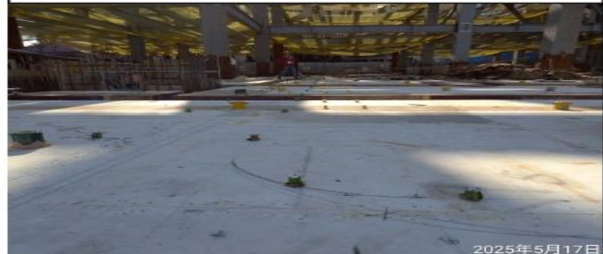
說明：1F樓版預埋施作。
