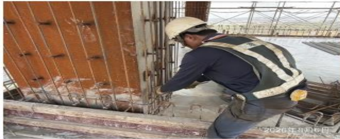
說明：柱筋綁紮。
