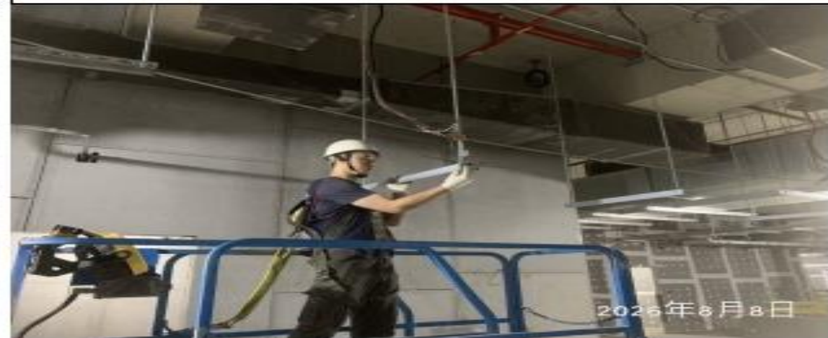
說明：管路吊架施作。
