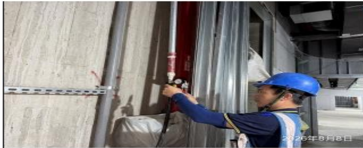
說明：管路持壓測試。
