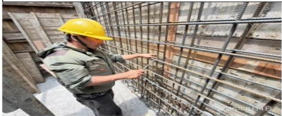
說明：牆筋綁紮。
