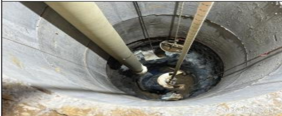
說明：Y4,X2基樁P7-2、P7-4挖掘及出土。
