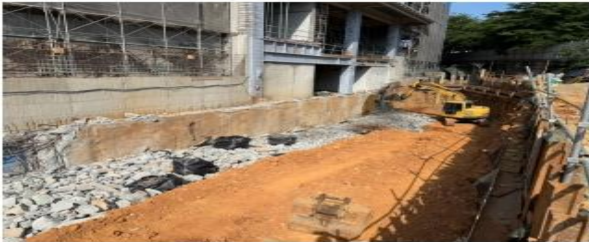
說明：北側外擴區擋土牆拆除。
