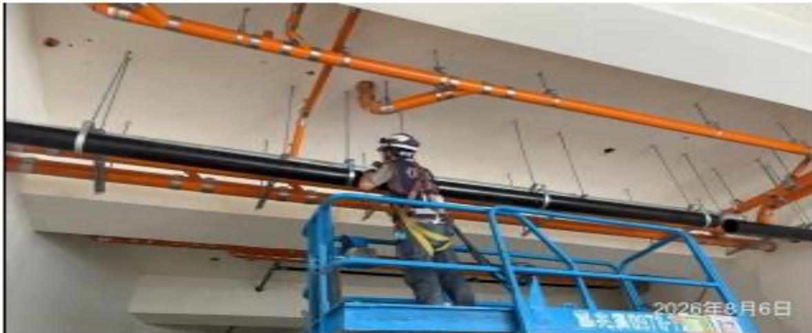
說明：排水管施作。
