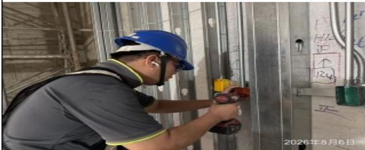
說明：預埋管路施作。
